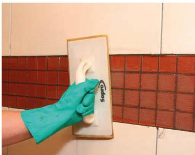
5 Zmywanie okładziny z mozaiki szklanej, gdy fuga tężeje w szczelinie.
