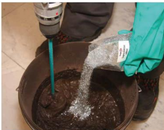
3 Opcjonalnie w trakcie mieszania można dodać maks. 80 g złotego lub srebrnego brokatu Sopro na 2 kg opakowanie fugi Sopro DF 10®. Wówczas ilość wody należy zwiększyć do zalecanej wartości.
