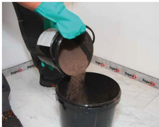
2 Dodać 2 kg fugi Sopro DF 10® i wymieszać mechanicznie.
