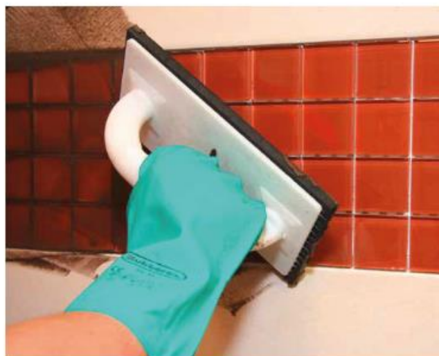
4 Spoinowanie mozaiki szklanej Sopro DF 10® ze srebrnym brokatem Sopro.
