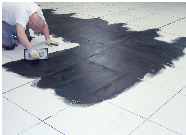
6 Spoinowanie okładziny zaprawą fugową Sopro FL z dodatkiem dyspersji Sopro ELD 458.
