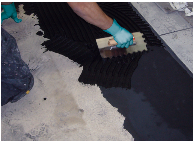
5 Układanie płyt ceramicznych na odprowadzającej ładunki elektryczne zaprawie klejowej cienkowarstwowej.
