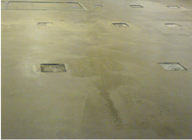
1 Powierzchnia podłogi wyrównana szpachlą samopoziomującą Sopro FS 15@ plus i zagruntowana pod kolejne prace okładzinowe.
