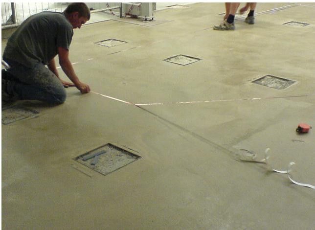
3 Naklejanie taśmy miedzianej w polach o odpowiedniej wielkości.
