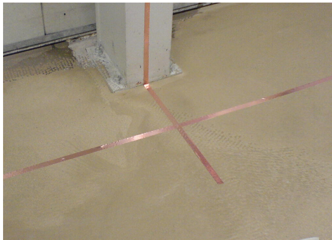
4 Ułożenie taśmy miedzianej na powierzchni pionowej dla późniejszego podłączenia do uziemienia.
