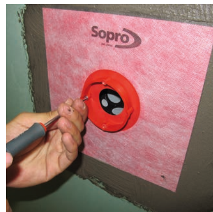
3 Wkręcanie pierścienia mocującego.
