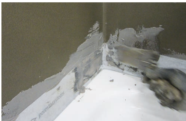
2 Narożnik taśmy uszczelniającej wklejany w łatwy sposób w naroże łazienki np. przy pomocy uszczelnienia Sopro DSF® 523.
