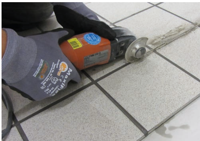
1 Wycięcie fugi z pierwszego rzędu płytek.
