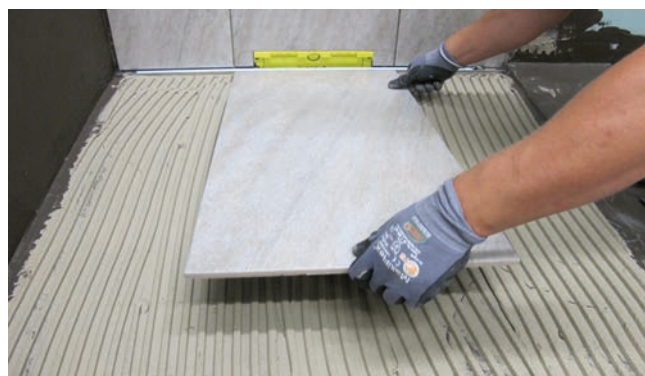
Układanie płytek na uszczelnieniu zespolonym z zastosowaniem systemowej, cienkowarstwowej zaprawy klejowej.
