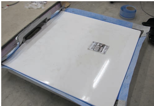
2 Po obwodzie brodzik ma zamontowany mankiet uszczelniający, który w dalszych pracach przyklejony jest do sąsiadujących powierzchni, a następnie pokryty uszczelnieniem zespolonym.
