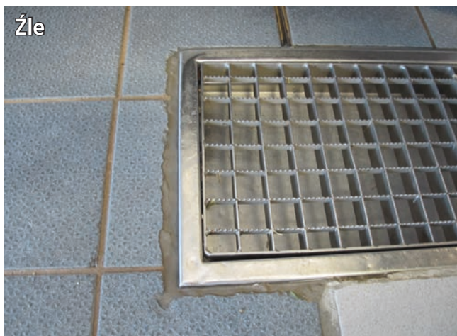
Rynna odwadniająca bez ramki – pobrudzone płytki i wyłamana część ich krawędzi.
