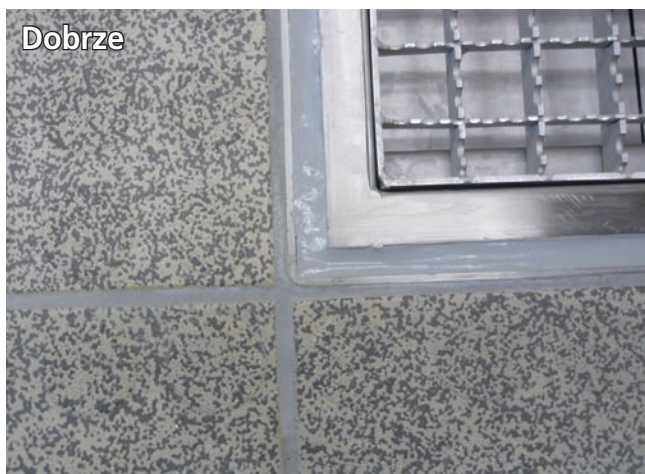
Rynna odwadniająca z ramką ze stali nierdzewnej. Lepiej rozwiązany problem wypełnienia szczeliny dylatacyjnej, zapewniający trwałość użytkowania.
