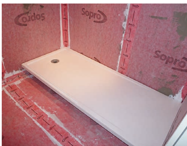
Uszczelniona powierzchnia, na której jest umieszczony brodzik prysznicowy.
