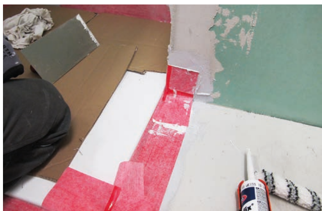
3 Połączenie brodzika prysznicowego z narożem w niszy z zastosowaniem uszczelki narożnej multi Sopro WDM 813.
