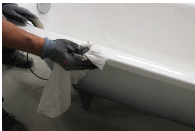
1 Oczyszczyć krawędzie wanny, usunąć wszystkie warstwy zmniejszające przyczepność.
