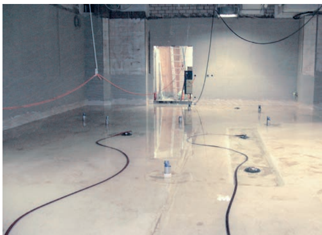
Próba szczelności uszczelnionej posadzki poprzez wykonanie próby wodnej.
