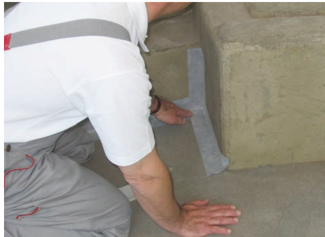
2 Wklejenie taśmy uszczelniającej Sopro FDB 524 w narożach.
