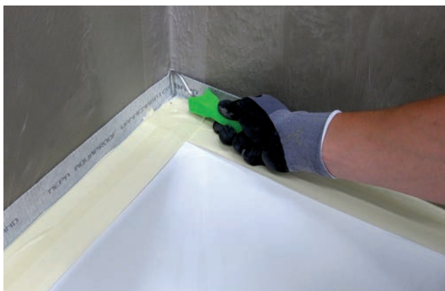
3 Taśma uszczelniająca ze względu na pionową perforację pozwala się dokładnie wkleić również w narożach ścian.
