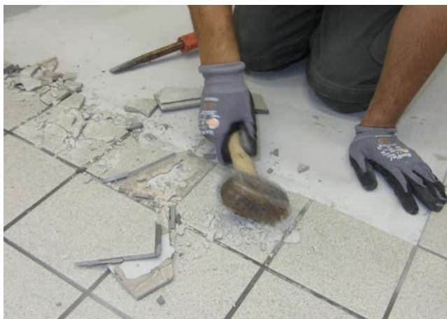
2 Pokruszenie płytki i ostrożny jej demontaż, bez uszkodzenia uszczelnienia.
