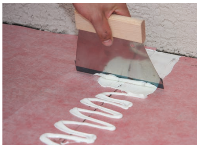
8 Rozprowadzenie kleju montażowego Sopro Racofix® RMK 818 w obszarze styku przy pomocy pacy zębatej.
