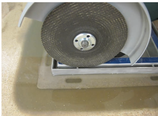
Po utwardzeniu mieszanki epoksydowej, bolec montażowy należy wyciąć, przed wypełnieniem szczeliny materiałem trwale elastycznym.
