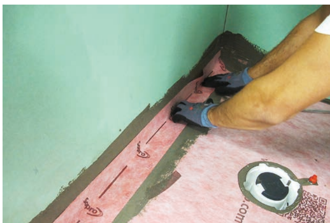
Układanie taśm uszczelniających w obszarze szczelin dylatacyjnych, na zaprawie uszczelniającej np. Sopro TDS 823.
