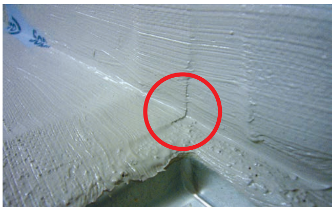
Taśma zatopiona w uszczelnieniu – szczelność połączenia.
