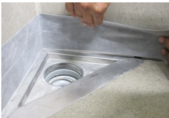
5 Starannie uszczelnione odwodnienie przy pomocy taśmy uszczelniającej samoklejącej Sopro FDB 524.
