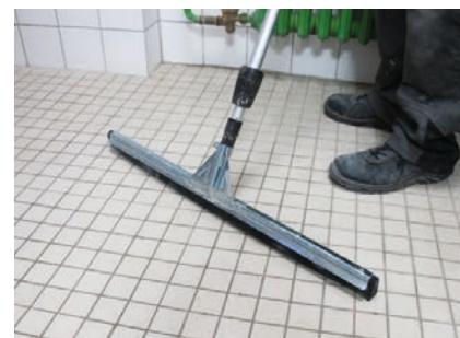
Usuwanie wody przy pomocy gumowej ściągaczki.
