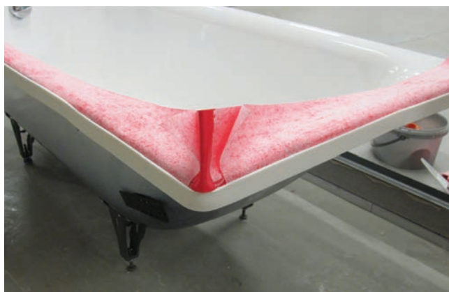
6 Przygotowana, gotowa do montażu wanna.
