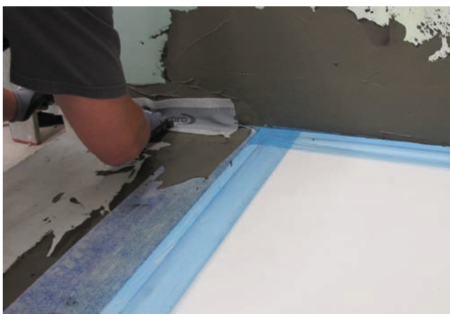
5 Uszczelnienie wykonane jest wokół brodzika przy pomocy zaprawy Sopro TDS 823.
