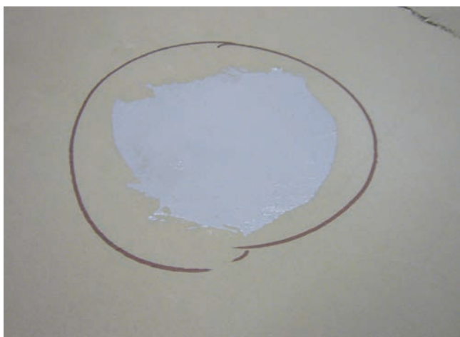
Staranne wypełnienie wyciętego miejsca i uzupełnienie powierzchni uszczelnienia.
