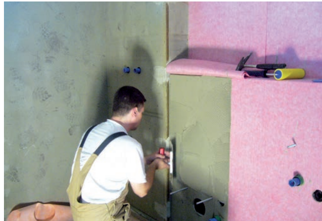
Uszczelnienie łazienki przy pomocy wstęgowego uszczelnienia zespolonego (mata uszczelniająco-odcinająca Sopro AEB® 640).
