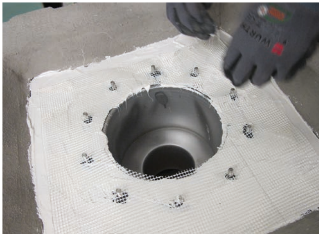
Przygotowanie elastycznej powłoki uszczelniającej Sopro PU-FD i połączenie z kołnierzem. W obszar kołnierza wbudowana siatka zbrojąca.
