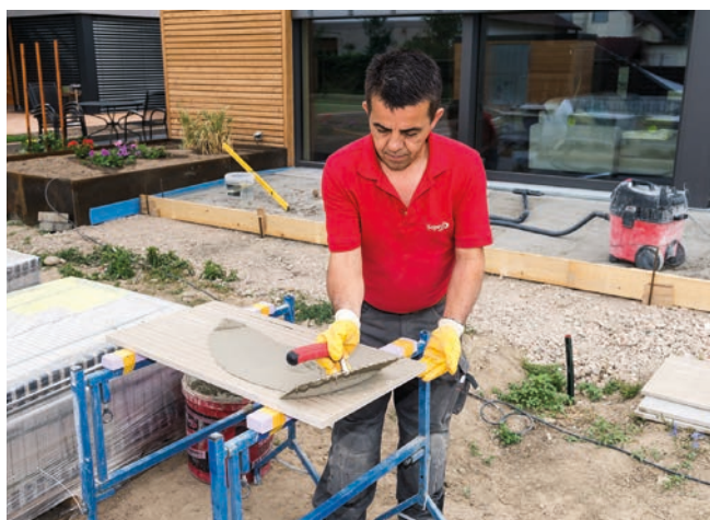
Naniesienie warstwy grzebieniowej zaprawy Sopro MEG 667 Silver na spódnią część płyty.
