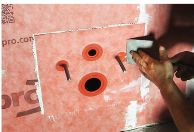
Uszczelka ścienna Sopro AEB® 1174 mocno dociśnięta do warstwy kleju.
