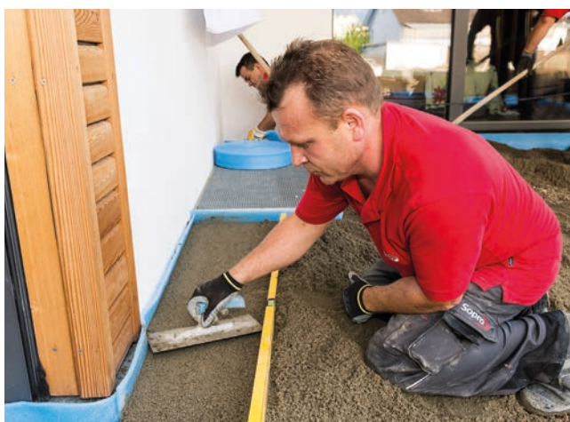
Układanie i wyrównanie warstwy zaprawy drenażowej na odpowiednią wysokość.
