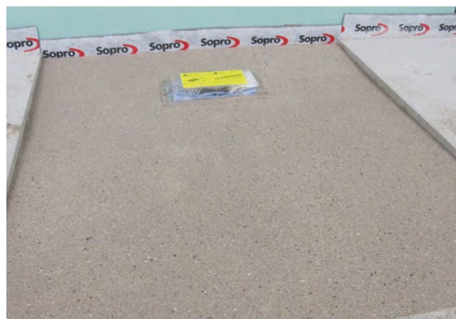
6 Powierzchnia natrysku wykonana zaprawą epoksydową na bazie Sopro BH 869, gotowa do dalszych prac, uszczelniających i glazurniczych.
