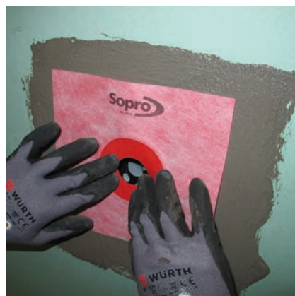
2 Nałożenie uszczelki ściennej Sopro AEB®.
