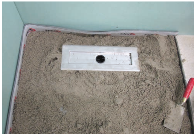
1 Montaż odpływu liniowego przy pomocy Sopro Rap'dur® M5.
