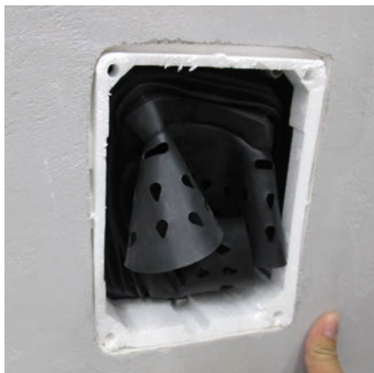
Niezawodne uszczelnienie armatury ściennej z zastosowaniem Sopro FDF 525 lub Sopro DSF® 523.
