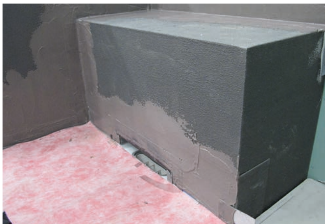
6 System Schedel do brodzika Xetis oferuje również ławę do siedzenia, która może być interesującym detalem wyposażenia łazienki. Odprowadzenie wody z brodzika Xetis wykonane jest w elemencie Schedel. Wszystkie powierzchnie są uszczelnione zaprawą Sopro TDS 823.
