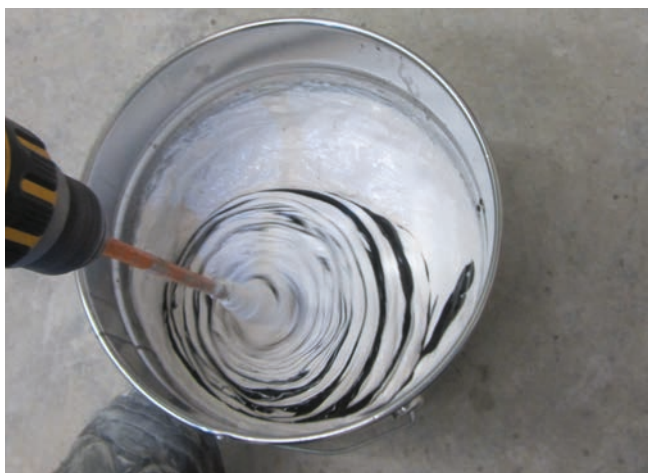
7 Farba kontrastowa Sopro PU-FD KF 572 mieszana z Sopro PU-FD – powstaje szare zabarwienie powłoki.
