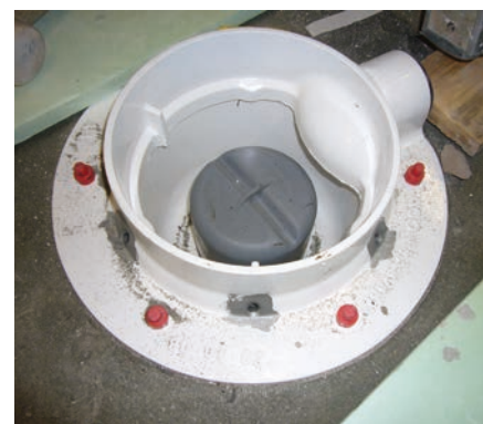
Odpiływ podłogowy z podwójnym odprowadzeniem wody do obiektów przemysłowych przygotowany do uszczelnienia.
