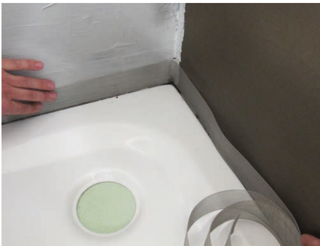
Taśma ochronna jest wbudowana podczas układania płytek.
