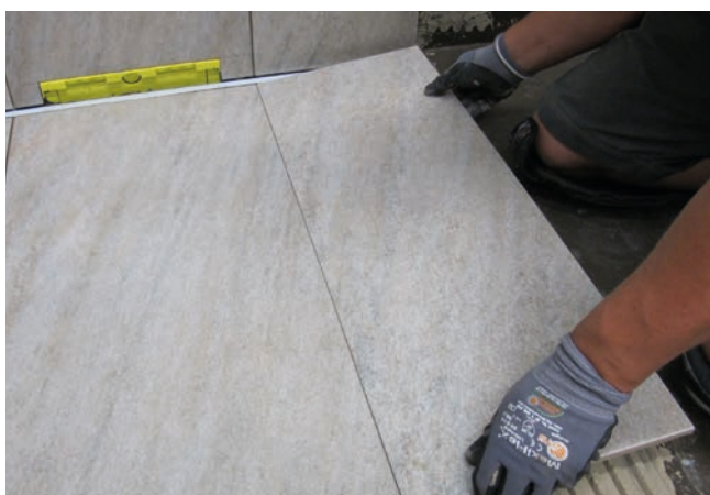
9 Płytki układane są do szyny zbierającej wodę.
