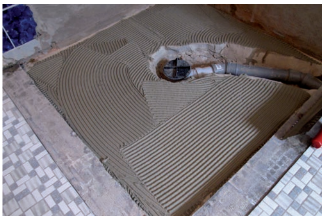
3 Element prysznicowy osadzony na zaprawie klejowej Sopro No.1 400 extra.
