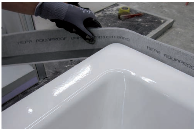
1 Taśmę uszczelniającą nakleić na krawędź wanny (System MEPA – Pauli und Menden GmbH).
