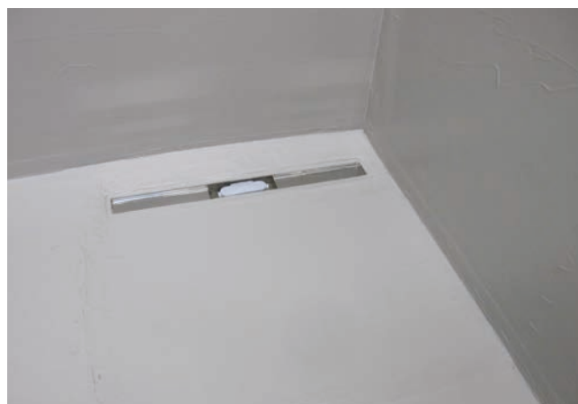
4 Gotowe, uszczelnione odwodnienie i powierzchnia naroża prysznicowego z użyciem uszczelnienia zespolonego (Sopro DSF® 523).
