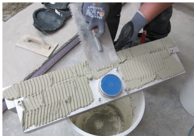
2 Pokrycie spodniej części odwodnienia zaprawą klejową Sopro No.1 400 extra dla poprawy przyczepności do jastrychu.
