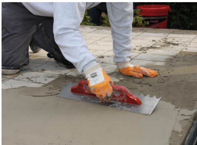
2 Wyrównanie ubytków i nierówności szpachlą wyrównawczą Sopro RAM 3 ® , przed rozpoczęciem prac uszczelniających.
