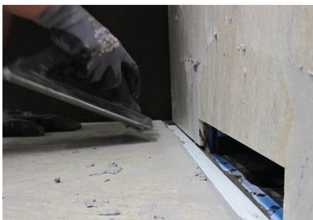
10 Do spoinowania okładziny można zastosować fugę Sopro DF 10®.
