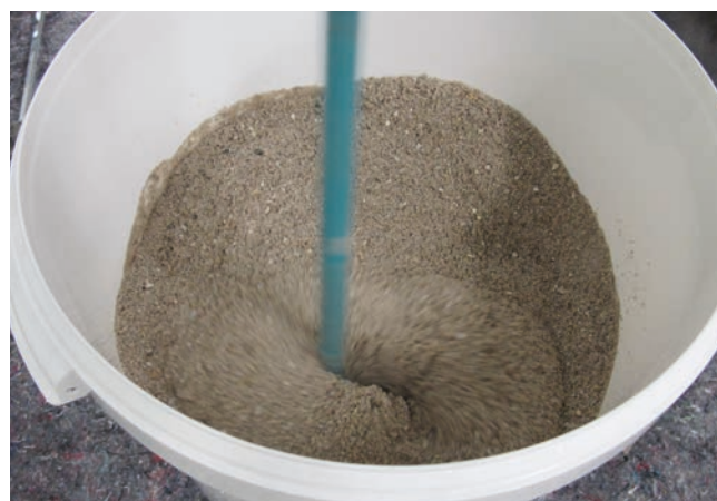
3+4 Mieszanie zaprawy epoksydowej do wytworzenia cienkowarstwowego jastrychu (Sopro BH 869 i Sopro EEK 871).
