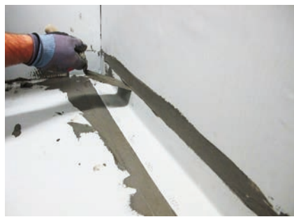
Taśmy uszczelniające i uformowane z nich elementy wklejone przy użyciu kleju wodoszczelnego Sopro FDK 415.
