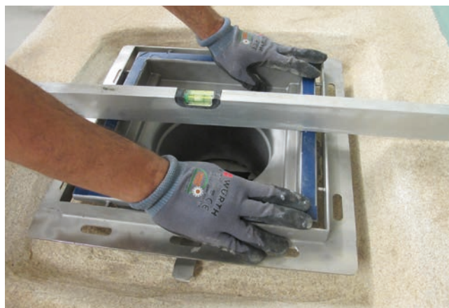
Górną część wpustu podłogowego (firma ETU) należy precyzyjnie ustawić na wymaganą wysokość i zamocować.
