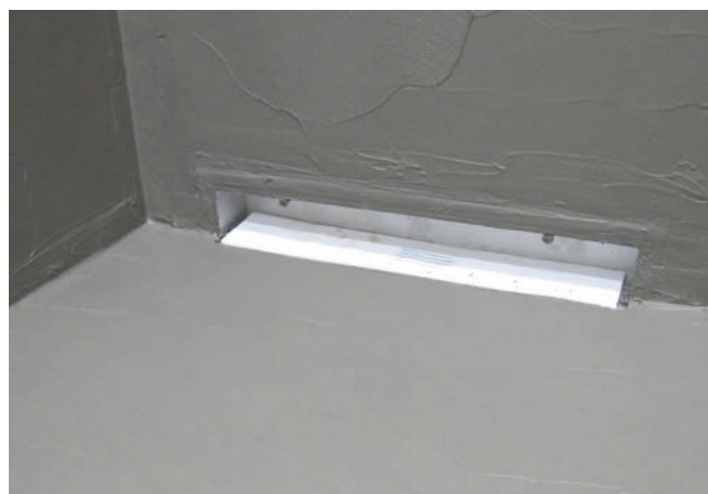
6 Uszczelnione naroże prysznicowe, gotowe do układania płytek.
