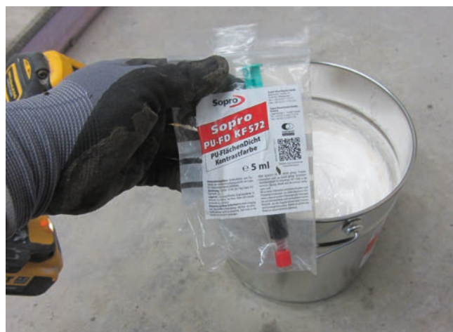
6 Farba kontrastowa Sopro PU-FD KF 572 może być dodana do materiału uszczelniającego Sopro PU-FD, aby dzięki różnicy kolorów między pierwszą i drugą warstwą łatwiej sprawdzić poprawność naniesienia uszczelnienia.
