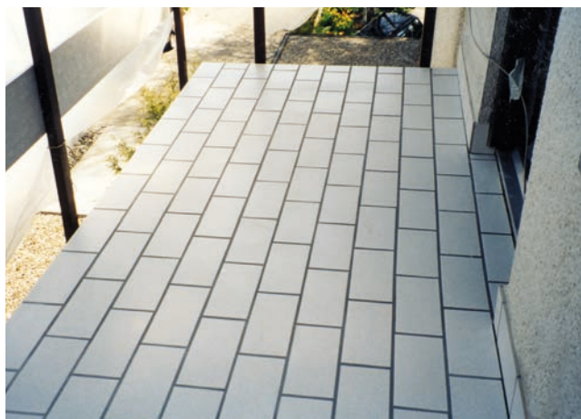
Balkon z okładziną ceramiczną.
