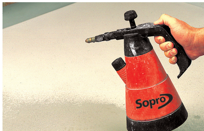
Lekkie nawilżenie podłoża przed nakładaniem elastycznej zaprawy uszczelniającej.
