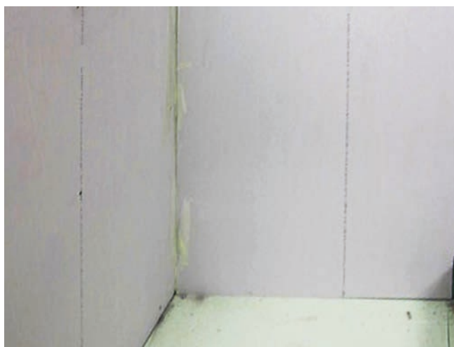
Cementowe płyty budowlane zastosowane w natrysku.
