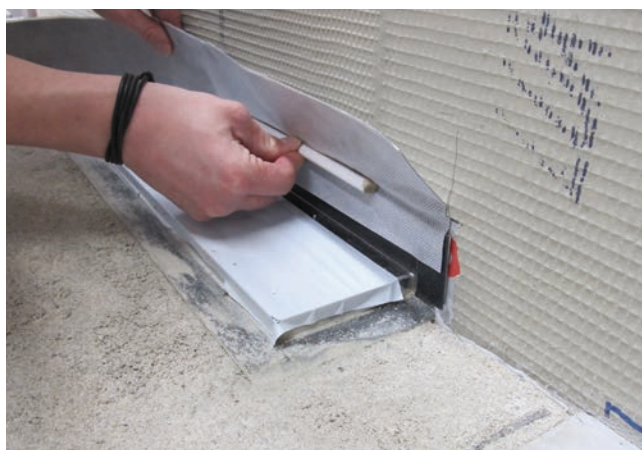
3 Taśma uszczelniająca Sopro FDB 524 jako element doszczelnienia między kołnierzem metalowym odwodnienia i przylegającym materiałem budowlanym.
