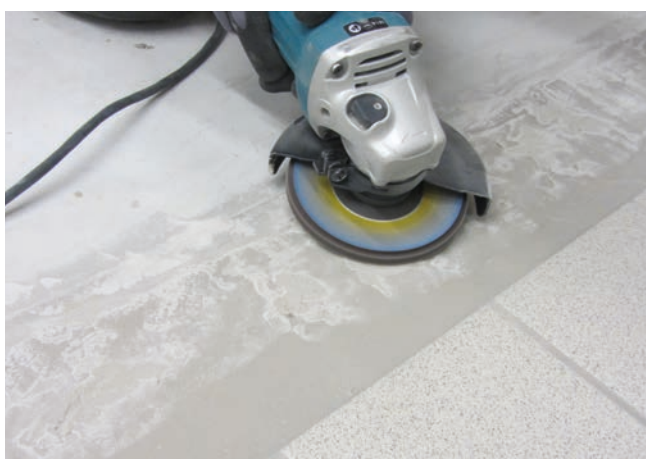
3 Zeszlifowanie pozostałości zaprawy klejowej i zeskosowanie uszczelnienie przy pomocy szlifierki kątowej.
