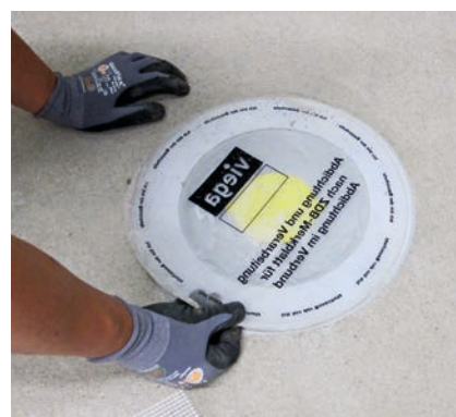
System Viega: odpływ podłogowy z kołnierzem, do połączenia z powłoką uszczelniającą.
