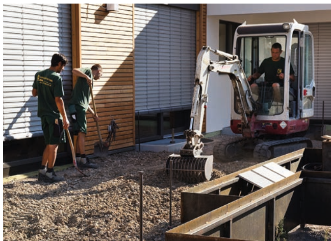
Układanie niezwiązanej warstwy podbudowy.
