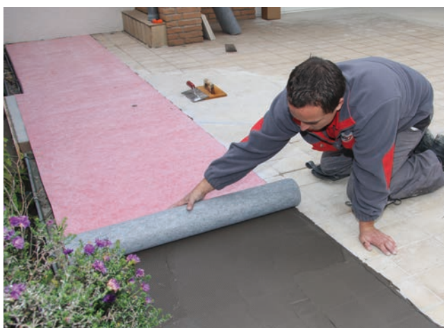
4 Ułożenie maty uszczelniająco-odcinającej Sopro AEB ® plus 639 na przygotowanej, świeżej zaprawie cienkowarstwowej.
