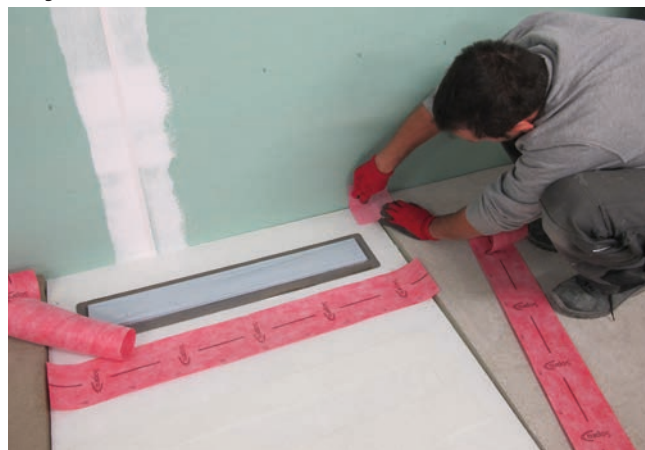
2 Wbudowanie galanterii uszczelniającej, m. in. taśm i narożników z ukształtowanym spadkiem Sopro AEB®.
