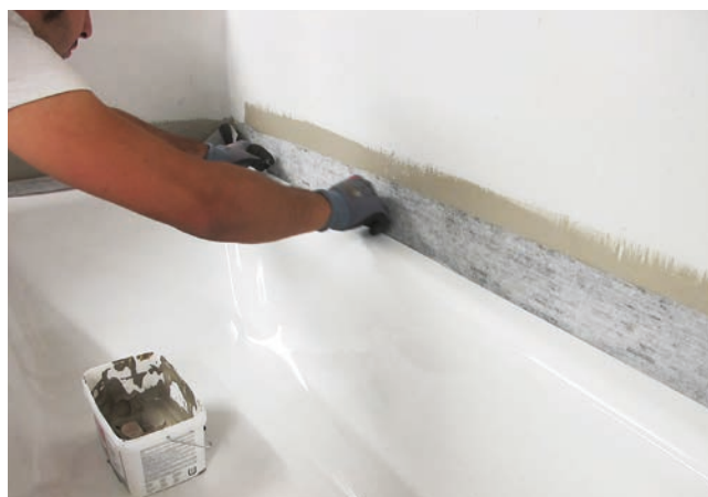
2 Uszczelnienie w obszarze ściany przy pomocy uszczelnienia Sopro FDF 525.
