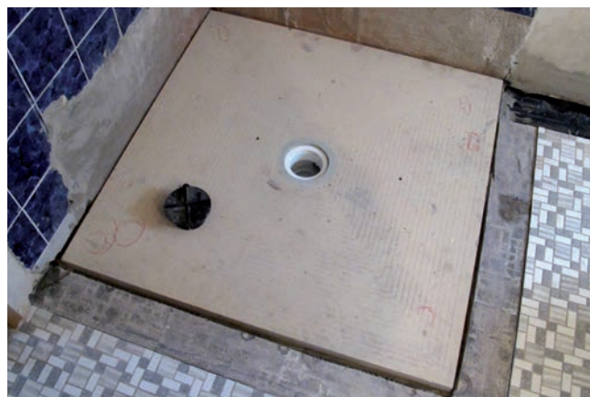
4 Zamontowany element naroża prysznicowego, gotowy do wykonania prac uszczelniających.
