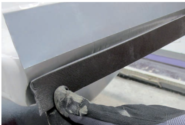
2 Dla uniknięcia mostków akustycznych przy montażu wanny nakleić pas pianki.
