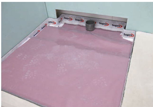
1 Przygotowanie naroża prysznicowego z wgłębieniem w ścianie do zabudowy odpływu liniowego.
