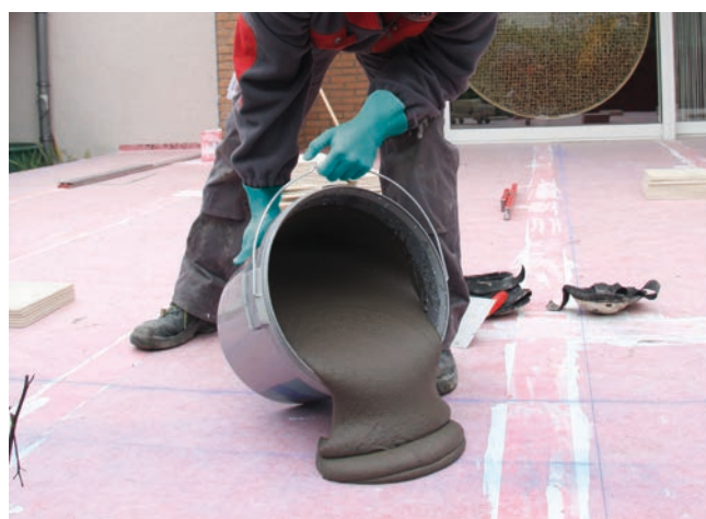
10 Cienkowarstwowa zaprawa klejowa Sopro MEG 667 Silver, przygotowana w konsystencji półpłynnej.
