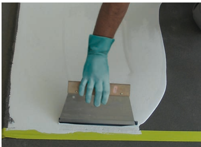
5 Nanoszenie uszczelnienia Sopro PU-FD 1571 na posadzkę w dwóch warstwach o łącznej grubości powłoki min. 1 mm.
