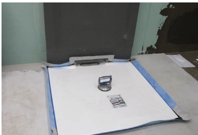
3 Brodzik jest osadzony w jastrychu, zlicowany z poziomem okładziny ceramicznej. Odpływ wody jest przesunięty na ścianę. Tu może okazać się pomocny element ścienny systemu Schedel.
