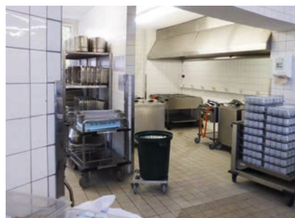
Nachylenia w kuchniach przemysłowych utrudniają codzienną pracę.
