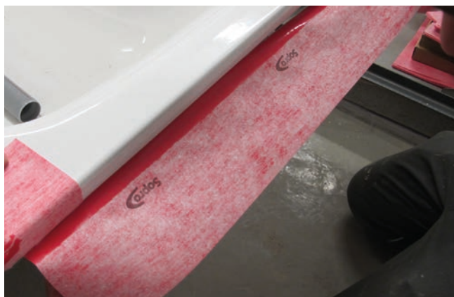
3 Nakleić wannową taśmę uszczelniającą Sopro WDB 811 tak, aby zachodziła co najmniej 50 mm na uszczelkę narożnikową.
