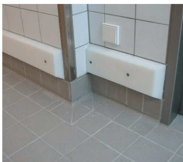
Wykonany element cokołu z ochroną odbojową.
