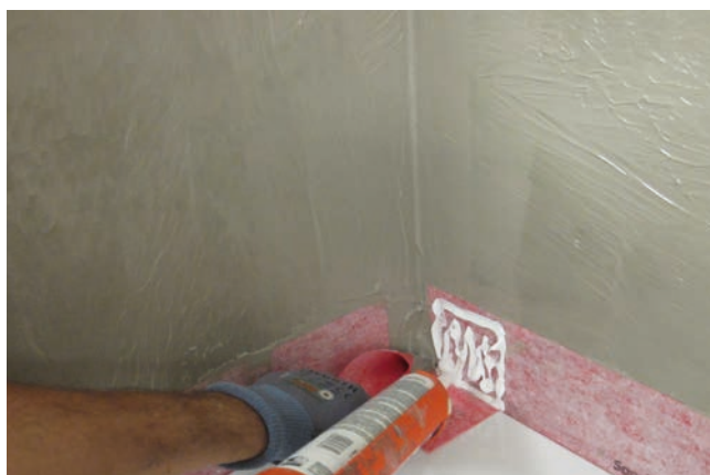
8 Uformowane elementy w obszarze łączenia krawędzi i zakładów skleić wodoszczelnie, np. klejem montażowym Sopro Racofix® RMK 818.
