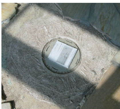
System ACO: wbudowany odpływ połączony z powłoką uszczelniającą.
