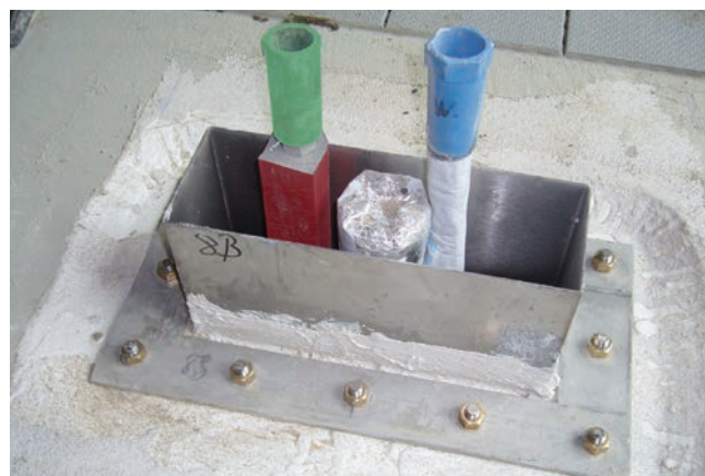
Przepust z kołnierzem, przystosowanym do zastosowania uszczelnienia zespolonego.
