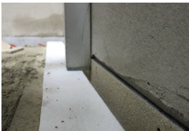
3 Montaż odwodnienia w jednej płaszczyźnie ze ścianą.
