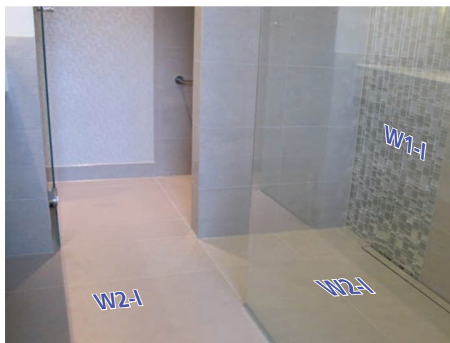
Łazienka z odpływem podłogowym, wykonanym w posadzce natrysku ze szklaną ścianką, chroniącą przed wodą rozpryskową.
