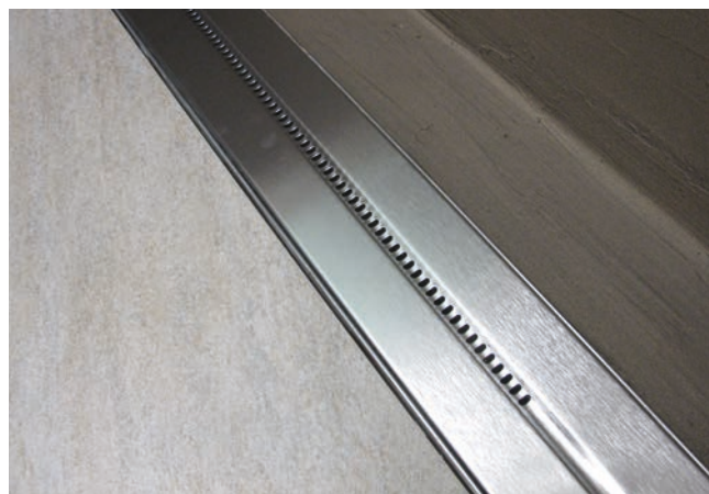
8 Gotowa posadzka natrysku z odwodnieniem liniowym ACO, pokryta okładziną ceramiczną.
