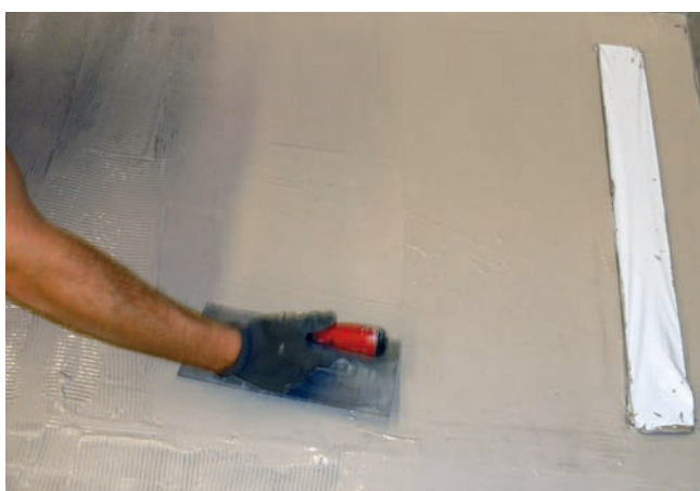
5 Uszczelnienie powierzchni ścian i posadzki przy użyciu Sopro DSF 523.
