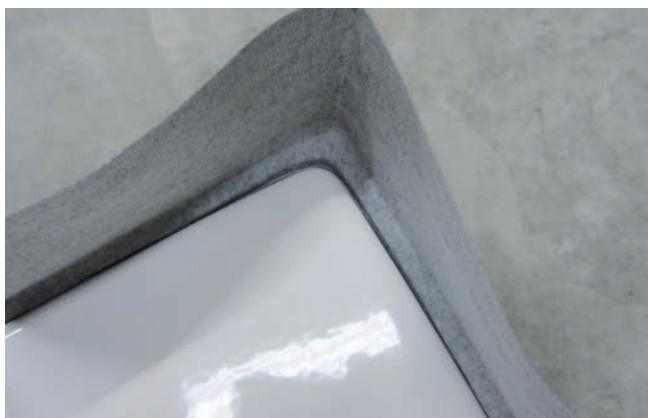
1 Gotowa, systemowa taśma uszczelniająca łatwo dopasowuje się do narożnika wanny, jak i do powierzchni ściany pod kątem 90°.
