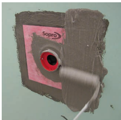
4 Uszczelnienie mankietu i pierścienia mocującego.
