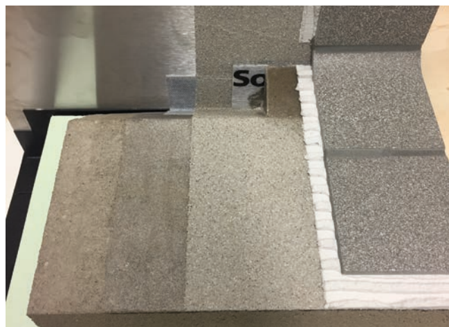
Połączenie płytki cokołowej z pomieszczeniem chłdnia.
