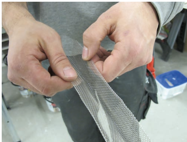
Wkładkę z taśmy można modelować według potrzeb.
