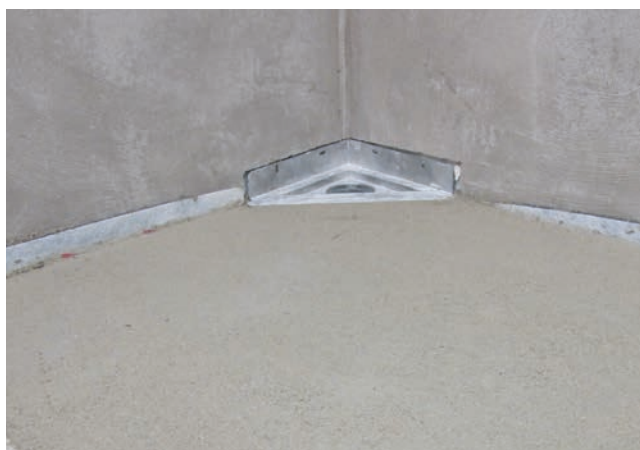
4 Powierzchnia posadzki natrysku ze spadkiem wykonana z użyciem zaprawy Sopro Rapidur® M5.
