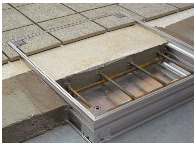
Wykonanie wodoszczelnego otworu rewizyjnego (ACO) w posadzce pomieszczenia mocno obciążonego.
