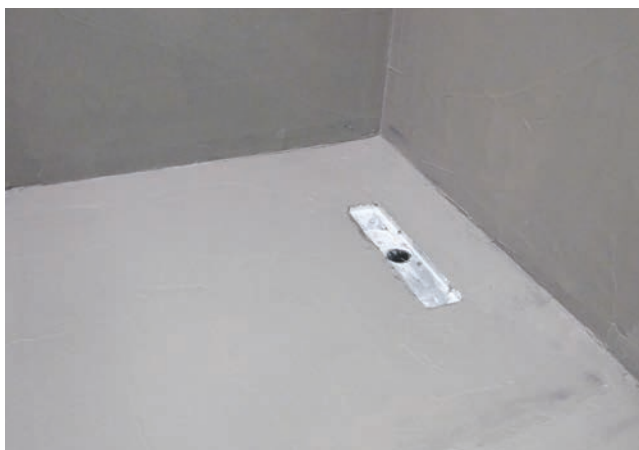
4 Uszczelnione przy użyciu zaprawy Sopro DSF® 523 naroże prysznicowe, gotowe do układania płytek.
