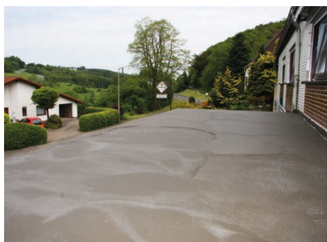
Taras/balkon uszczelniony cementową, elastyczną zaprawą uszczelniającą Sopro TDS 823, przygotowany do układania płytek.
