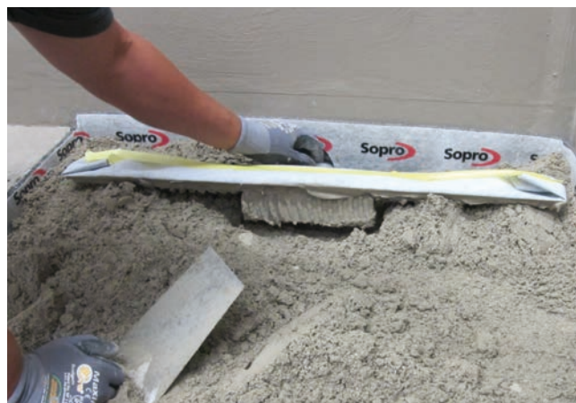
2 Odwodnienie wbudowane w jastrych Sopro Rapidur® M5 z zastosowaniem zaprawy cienkowarstwowej Sopro No.1 400 extra jako warstwy kontaktowej między korpusem odwodnienia i jastrychem.
