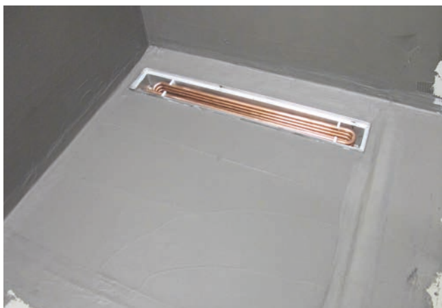
7 Uszczelniona powierzchnia z energooszczędnym odwodnieniem liniowym ACO.
