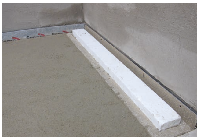
4 Wbudowanie odwodnienia liniowego w jastrych Sopro Rapidur® M5.
