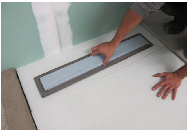
1 Dopasowanie odwodnienia liniowego do gotowego elementu posadzki natrysku.
