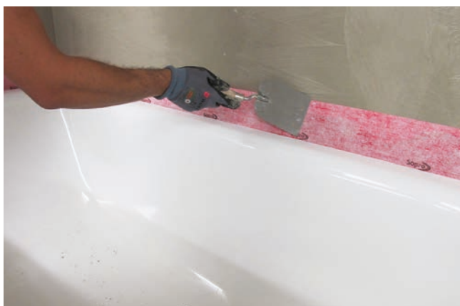
7 Odcinki taśmy przykleić do ściany przy użyciu płynnego materiału uszczelniającego (Sopro DSF® 523/Sopro FDF 525).
