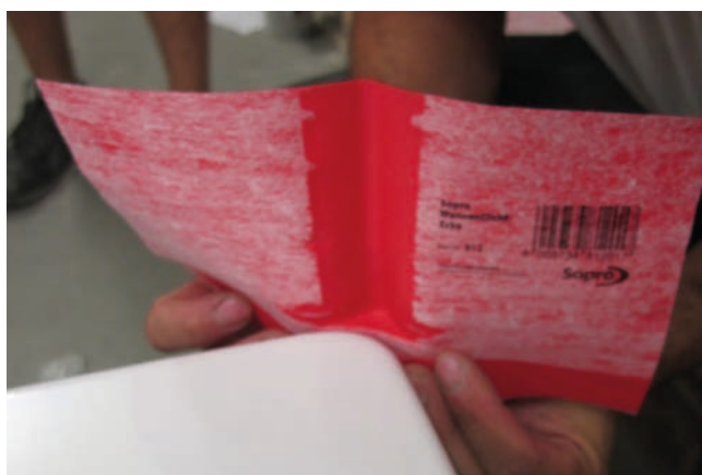
2 Nakleić wannową uszczelkę narożnikową Sopro WDE 812, która w dolnej części dopasowuje się do narożnika wanny i powierzchni połączenia ze ścianą pod kątem 90°.
