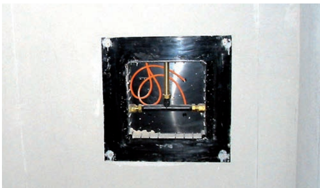
Armatura pod tynkiem z kołnierzem do połączenia z uszczelnieniem...
