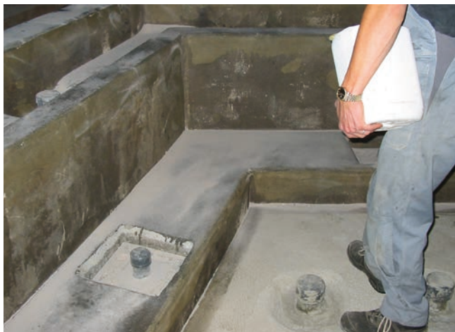
1 Nanoszenie preparatu epoksydowego Sopro EPG 1522 z posypką z piasku kwarcowego Sopro QS 507.
