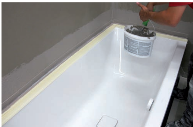
4 Uszczelnienie taśmy (System MEPA – Pauli und Menden GmbH) w obszarze ściany przy pomocy Sopro FDF 525.
