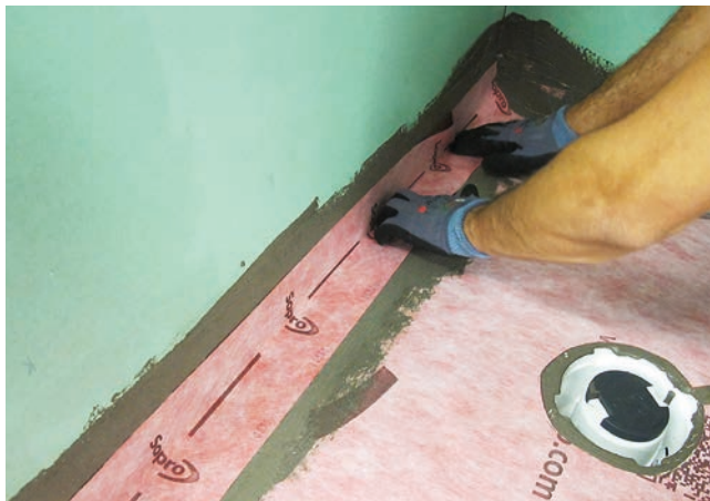
4 Wkleić elementy uszczelniające (narożniki i taśmy).
