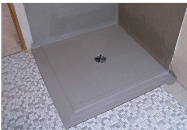
5 Odpływ uszczelniony Sopro DSF® 523 w dwóch warstwach.
