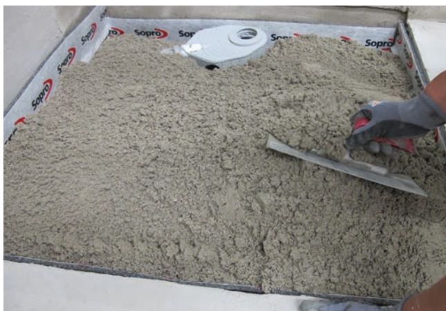
1 Wbudowanie korpusu wpustu przy użyciu jastrychu Sopro Rapidur® M5.
