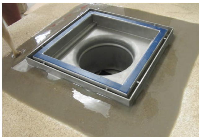
Odpływ podłogowy po związaniu żywicy mocno połączony jest z konstrukcją posadzki i może być poddany wysokim obciążeniom.
