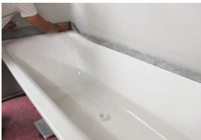
1 Wanna z naklejoną taśmą uszczelniającą (System Franz Kaldewei GmbH & Co. KG) zamontowana przy ścianie.
