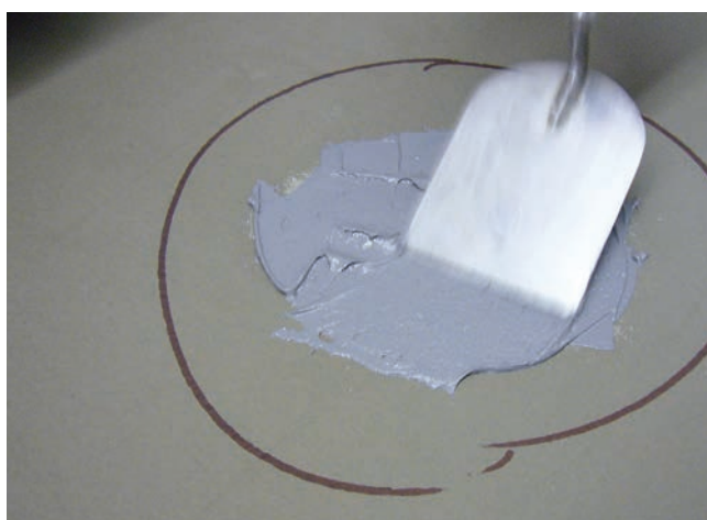
Wypełnienie wycięcia uszczelnieniem zespolonym.
