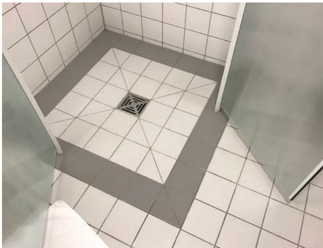
Powierzchnia brodzika prysznicowego z profilowanym obrzeżem o różnicy wysokości 1 cm.
