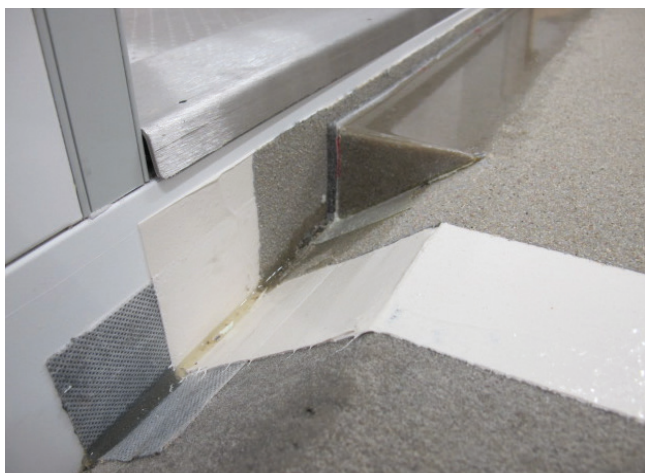
Powłoka uszczelniająca Sopro PU-FD jest aplikowana bezpośrednio na ścianę chłodni.
