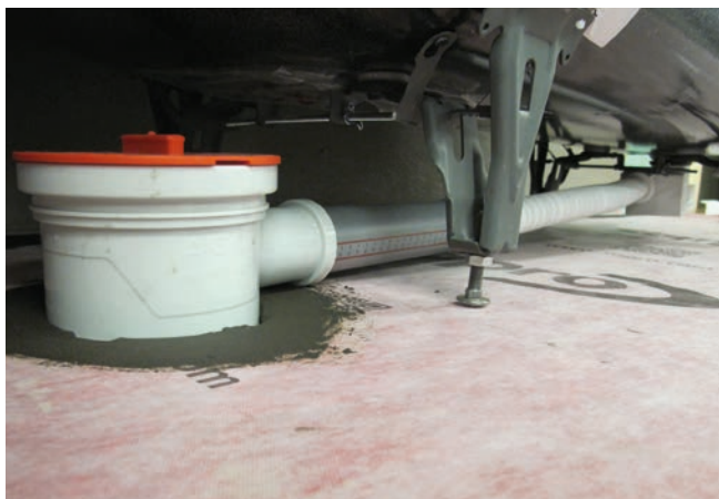
7 Woda z wanny łatwo odpływa przez system odwadniający. Równocześnie w przypadku awarii, woda może spłynąć po powierzchni uszczelnienia do drugiego odprowadzenia wody.
