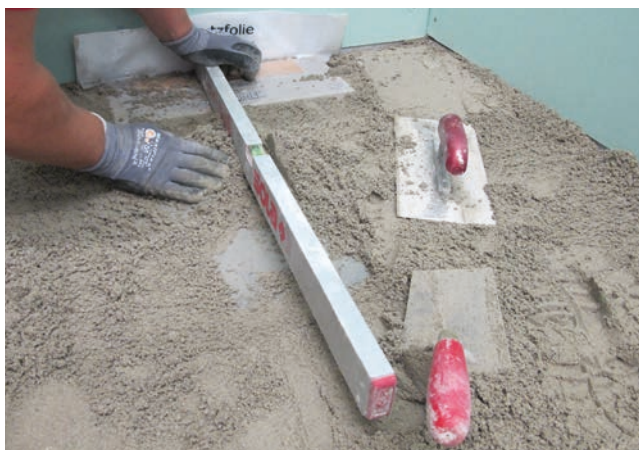
2 Wbudowanie elementu odpływu odwodnienia podłogowego w warstwę jastrychu, wytworzonego z Sopro Rap'dur® M5 z odpowiednim spadkiem.
