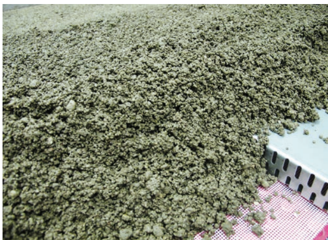
11 Zaprawa drenażowa ułożona na kanale.
