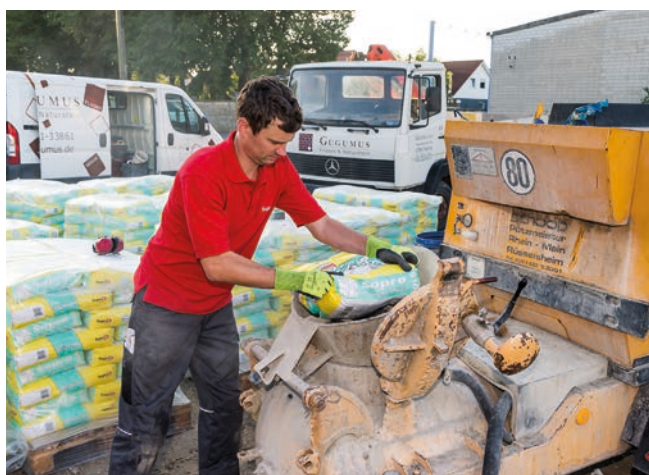
Mieszanie zaprawy drenażowej przy pomocy pompy do jastrychów.
