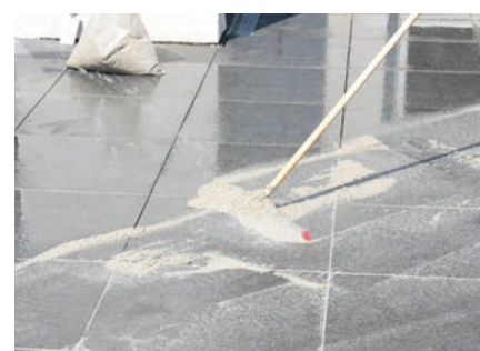
Łatwe spoinowanie fugą drenażową Sopro Solitär® F20 przy pomocy strumienia wody i gumowej rakli.
