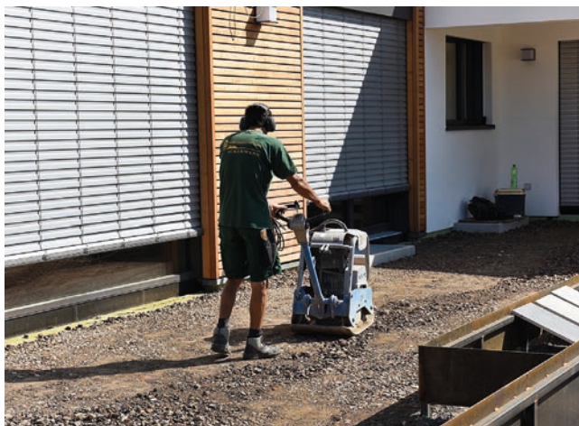
Zagęszczenie niezwiązanej warstwy nośnej.
