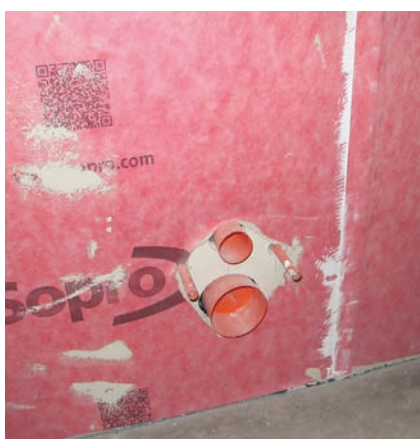
Uszczelniona ściana toalety.
