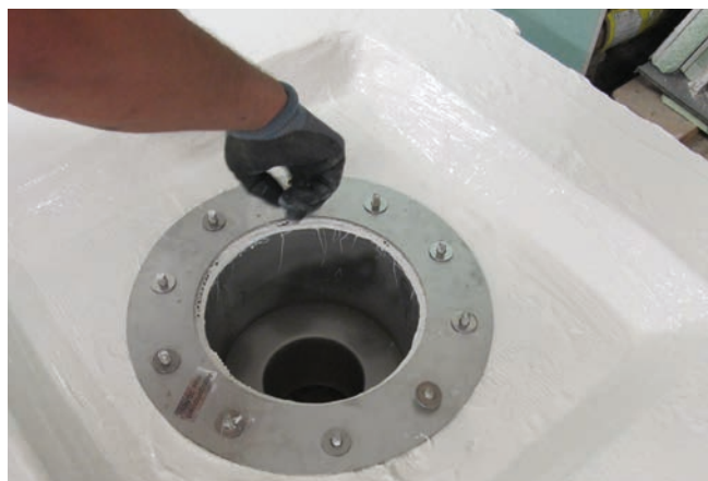
Uszczelniony korpus wpustu z kołnierzem, gotowy do montażu górnej części wpustu.
