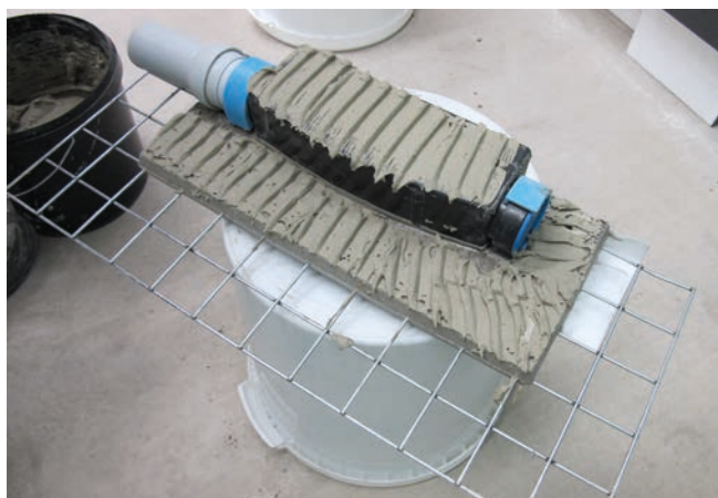
1 Pokrycie spodniej części elementu odwodnienia podłogowego systemu Dallmer zaprawą klejową Sopro No.1 400 extra dla poprawy przyczepności do jastrychu.
