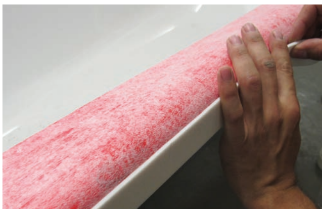
5 Gdy uformowane elementy taśmy uszczelniającej zostały zamocowane, przykleić taśmę akustyczną Sopro WDS 814.
