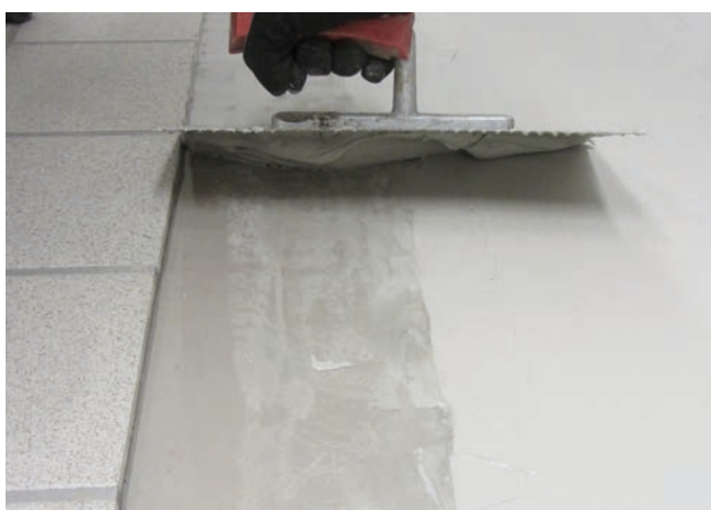
4 Nałożenie na zakładkę warstwy uszczelnienia zespolonego w narożu prysznicowym.
