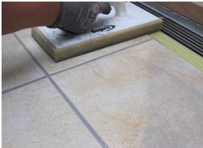
7 Spoinowanie powierzchni okładziny fugą elastyczną Sopro FL plus.
