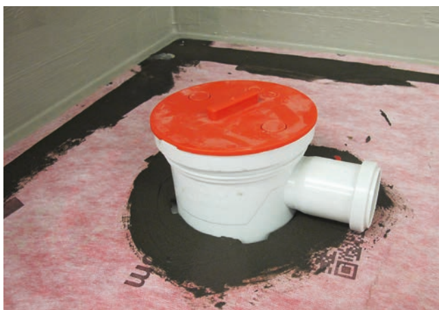
6 Montaż nasadki odwadniającej wpustu z podwójnym odprowadzeniem wody.
