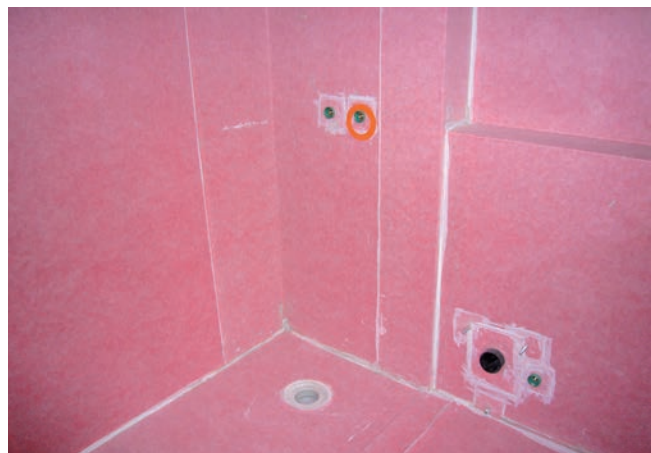
Zakończone prace uszczelniające – dobrze widoczny jest obszar łączni krawędzi mat Sopro AEB®, które zostały wodoszczelnie przyklejone klejem montażowym Sopro Racofix® RMK 818.
