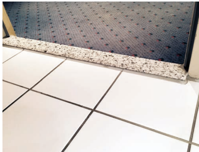
Okładzina z progiem kamiennym.
