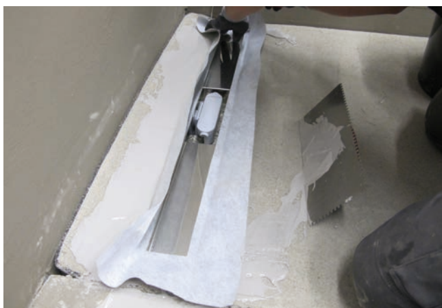
3 Wklejenie kolnierza uszczelniającego na zaprawie Sopro DSF® 523.
