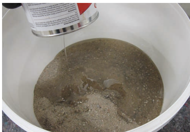
3+4 Mieszanie zaprawy epoksydowej do wytworzenia cienkowarstwowego jastrychu (Sopro BH 869 i Sopro EEK 871).
