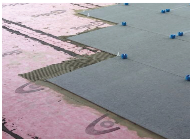
12 Układanie płyt metodą kombinowaną na przygotowanej zaprawie klejowej.
