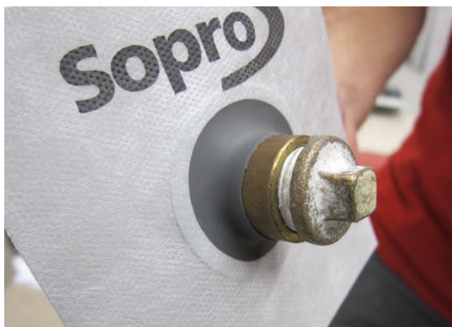
Dokładne i szczelne połączenie rury doprowadzającej wodę z elastyczną, środkową strefą uszczelki Sopro DWF 089.
