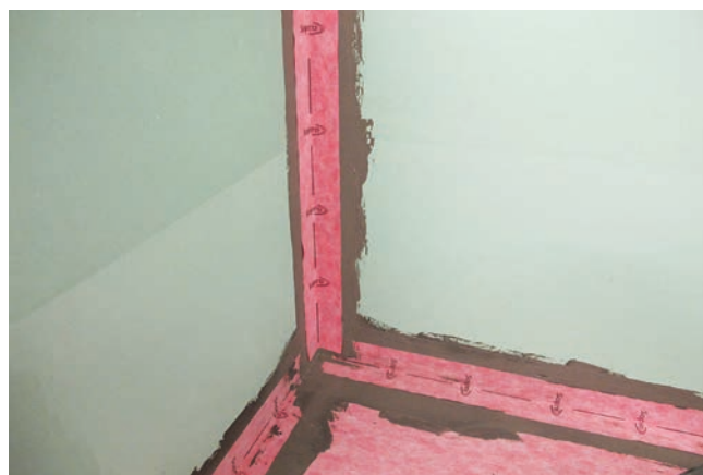
Układanie taśm uszczelniających w obszarze szczelin dylatacyjnych, na zaprawie uszczelniającej np. Sopro TDS 823.
