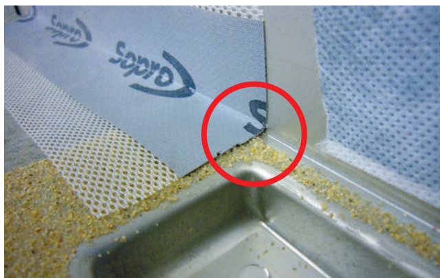
Taśma dokładnie przylega do stalowej powierzchni kołnierza.
