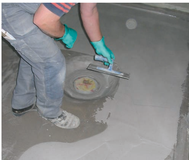
Nanoszenie elastycznej, mineralnej zaprawy uszczelniającej.
