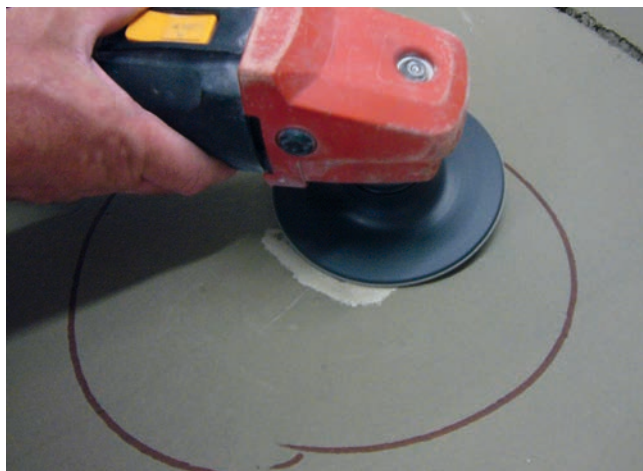
Zeszlifowanie krawędzi punktu pomiaru, łagodne sfazowanie.
