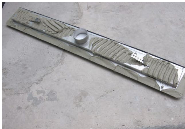
2 Spodnia część rynny odwodnienia pokryta jest zaprawą klejową Sopro No.1 400 extra dla poprawy przyczepności do jastrychu.
