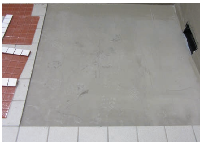
5 Powierzchnia naroża z naniesionym uszczelnieniem zespolonym Sopro DSF® 523. Po jego wyschnięciu można przystąpić do układania mozaiki.
