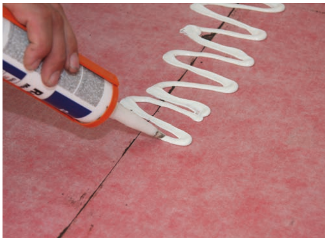
7 Nałożenie kleju montażowego Sopro Racofix® RMK 818 do uszczelnienia połączeń krawędzi mat Sopro AEB® plus 639.
