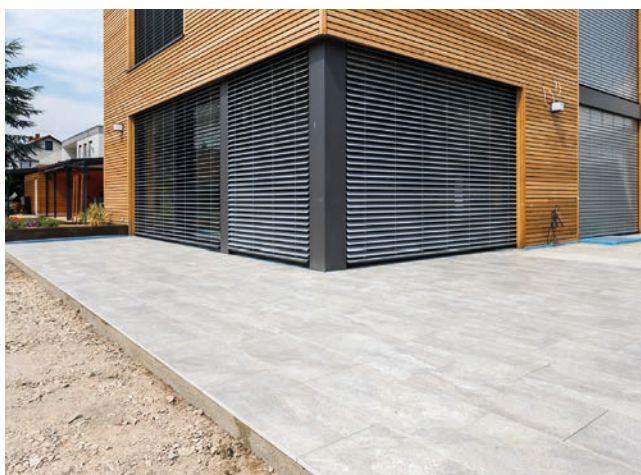
Ułożona okładzina, gotowa do spoinowania fugą Sopro FL plus.
