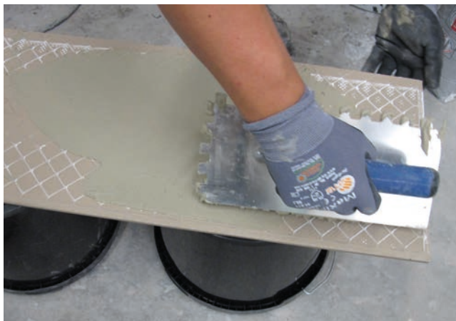
8 Płyty wielkoformatowe układane są metodą kombinowaną.
