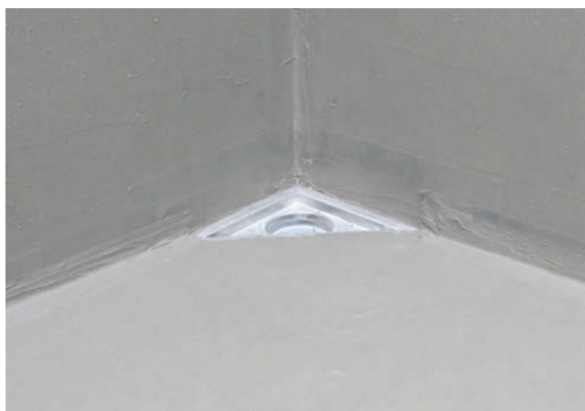
6 Naroże przysznicowe uszczelnione zaprawą Sopro DSF® 523 lub Sopro TDS 823.
