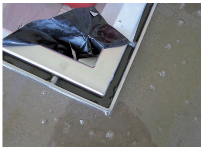
Obramowanie ze stali nierdzewnej jest dobrze widoczne. Bolce łączące są później zerwane, korpus odwodnienia może swobodnie się przemieszczać.
