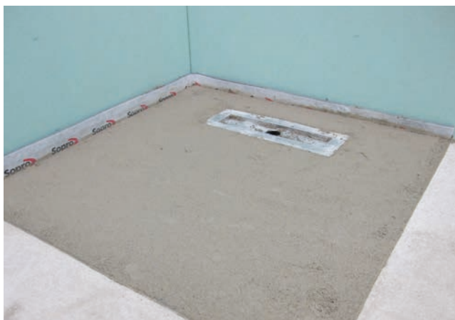
2 Powierzchnia posadzki naroża prysznicowego ze spadkiem w kierunku odpływu, wymodelowanym w świeżym jastrychu.
