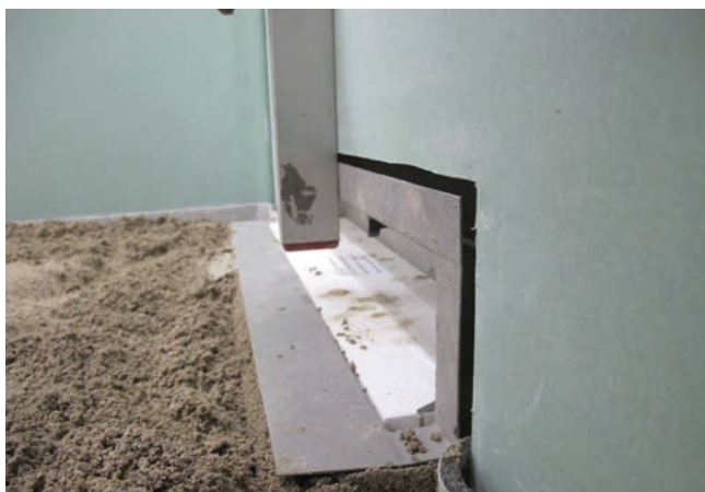
3 Osadzenie korpusu odwodnienia w jastrychu Sopro Rapidur® M5 w jednej płaszczyźnie ze ścianą.
