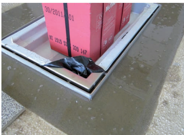
Żywiczne uszczelnienie kapilarne odwodnienia liniowego wykonane mieszkanką epoksydowo-piaskową (Sopro EPG 1522 zmieszane w proporcji 1:1:1 z Sopro QS 507 i Sopro QS 511). Odpływ poprzez zastosowanie obciążnika jest zabezpieczony przed przemieszczeniem na czas wykonania korka epoksydowego.
