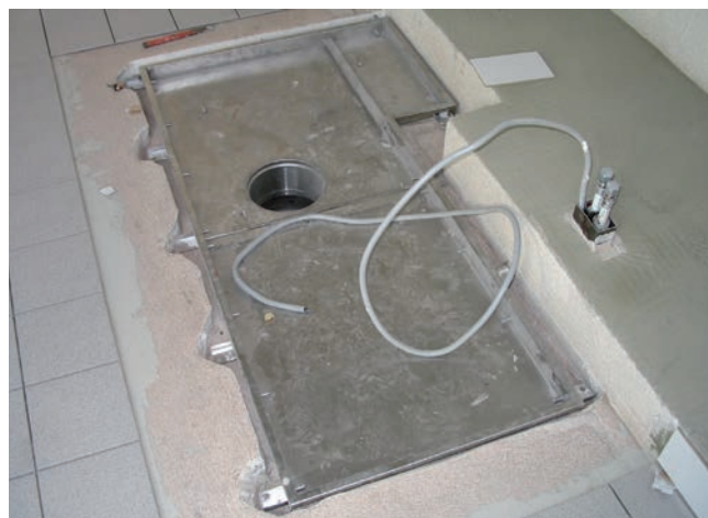
Odwodnienie osadzone w uszczelnionym zagłębieniu.
