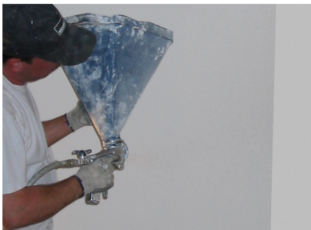
8 Nanoszenie piasku kwarcowego na świeżo położoną drugą warstwę elastycznej powłoki uszczelniającej Sopro PU-FD.
