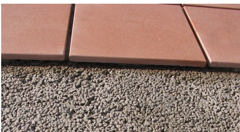
Układanie płytek na jastrychu drenażowym metodą cienkowarstwową.
