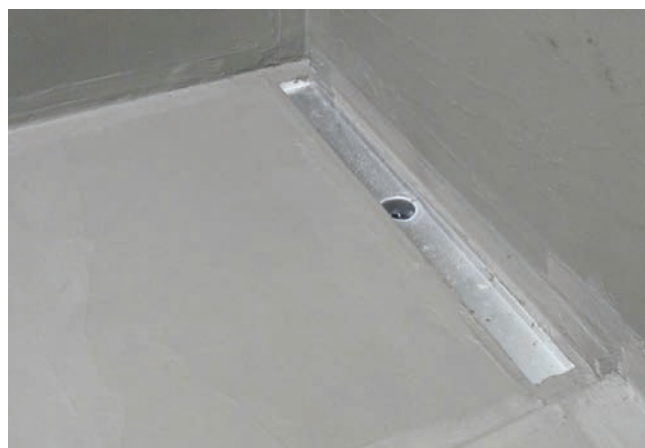
6 Uszczelnione naroże prysznicowe (2 warstwy), gotowe do układania płytek.
