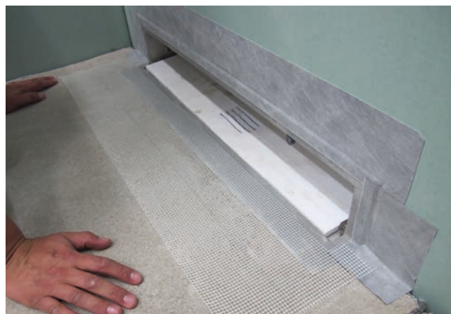
4 Powierzchnia natrysku Sopro Rapidur® M5 z zamontowanym ściennym odpływem liniowym.
