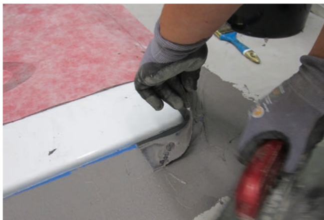
5 Krawędzie mankietu uszczelniającego są zatopione w uszczelnieniu zespolonym Sopro TDS 823.
