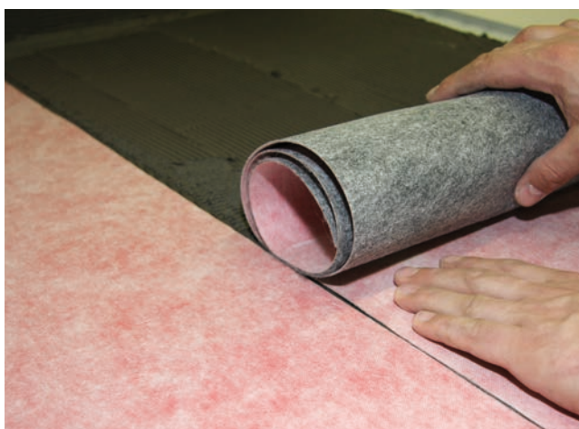
6 Układanie odcinków mat Sopro AEB ® plus 639 na styk.
