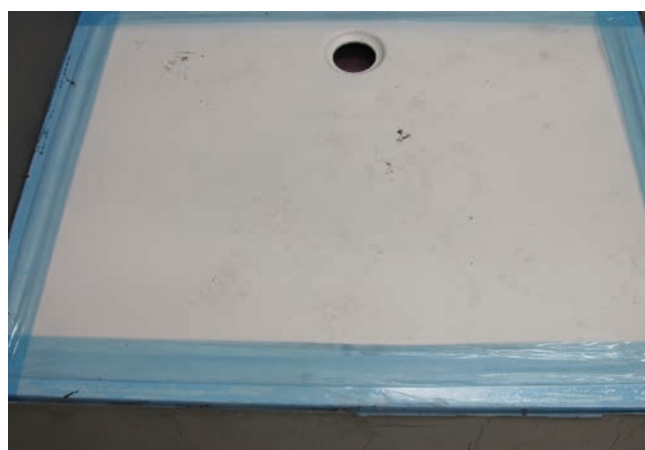
6 Naroże prysznicowe estetycznie i skutecznie uszczelnione przy użyciu Sopro TDS 823.
