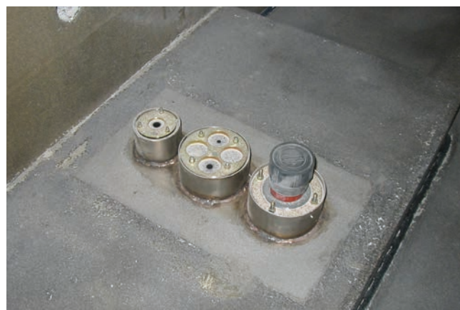
Płyta przepustowa z okrągłymi uszczelkami gumowymi.
