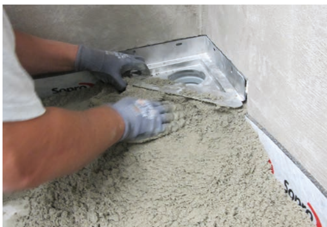
3 W obszarze ściany dokładnie osadzić element odwodniający, aby dobrze przylegał do powierzchni ściany.
