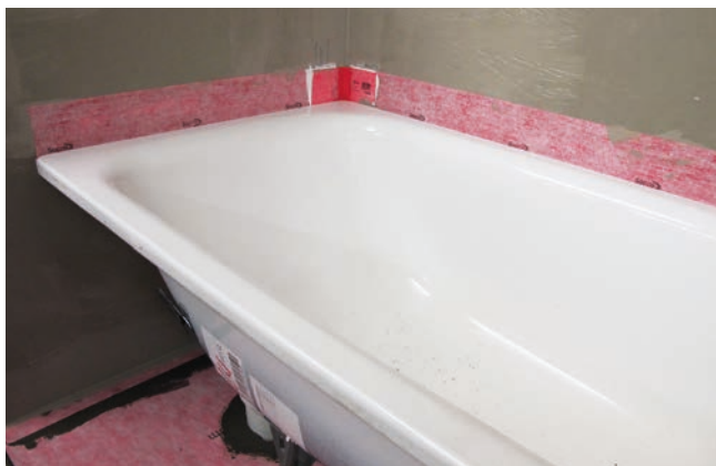
9 Wanna uszczelniona przy pomocy wannowego systemu uszczelniającego Sopro. Powłokę uszczelniającą ścianę można teraz nałożyć na taśmy.
