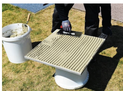
Klej, np. Sopro No.1 400 extra, naniesiony na spodnią część płyty.
