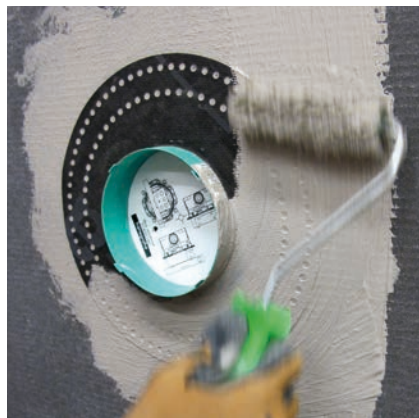
Elementy armatury podtynkowej, które nie mają mankietu uszczelniającego z elastyczną strefą.
