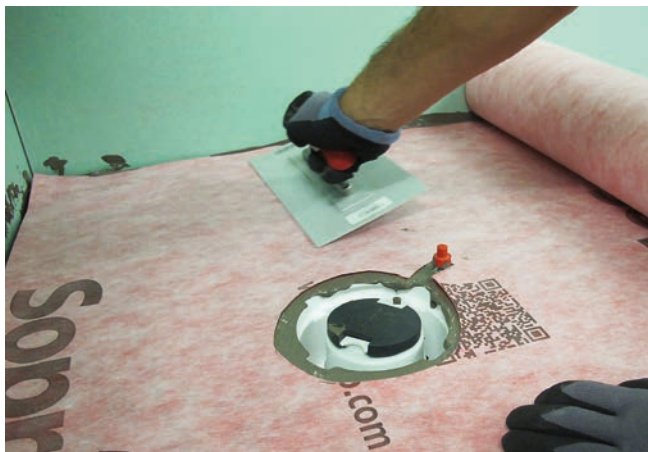
3 Matę Sopro AEB® 640 mocno docisnąć do warstwy kleju Sopro FDK 415.
