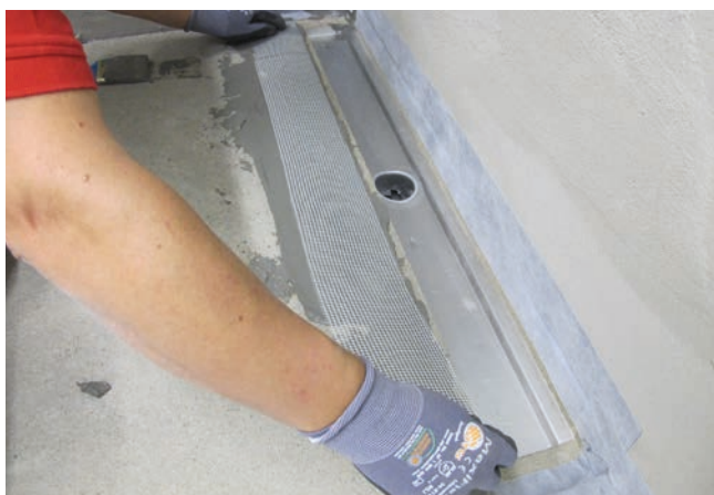
5 Uszczelnienie rynny przy pomocy systemowych taśm uszczelniających/siatki zbrojącej i Sopro TDS 823.
