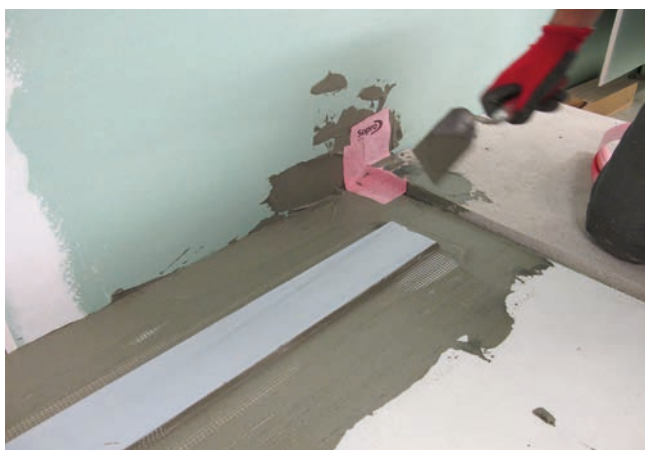
3 Taśmy i uszczelki wklejone na zaprawie uszczelniającej Sopro TDS 823.
