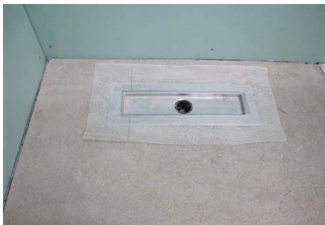
3 Ułożenie systemowej taśmy lub siatki zbrojącej dla uszczelnienia obszaru między odwodnieniem i jastrychem.
