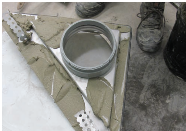
2 Dla uzyskania poprawy przyczepności między jastrychem a elementem odwodnienia narożnego, jego spodnią część należy pokryć zaprawą klejową Sopro No.1 400 extra.
