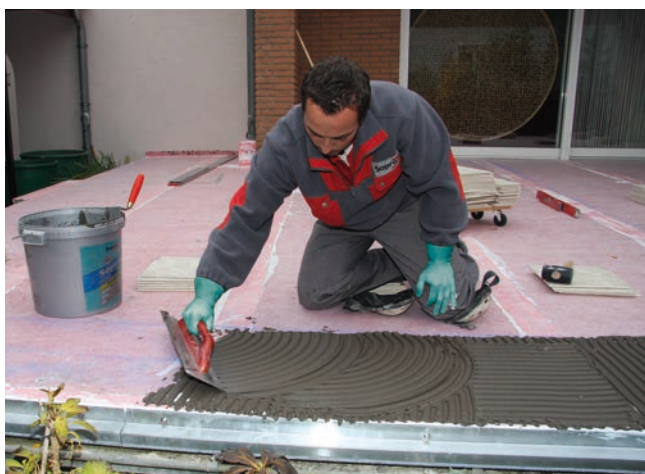
11 Nałożenie warstwy grzebieniowej zaprawy klejowej Sopro MEG 667 Silver.
