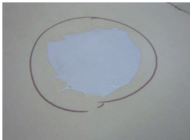
Dokładne wypełnienie wyciętego miejsca i uzupełnienie powierzchni uszczelnienia.
