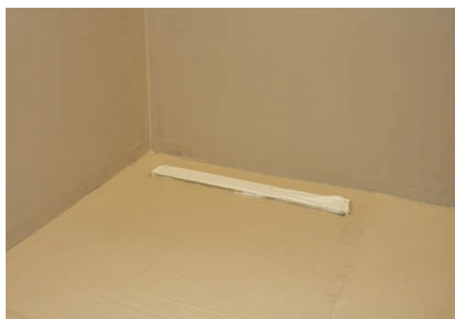
6 Naroże prysznicowe uszczelnione Sopro DSF 523 w 2-ch warstwach (obszar ścian i posadzki) pod układane płytki.
