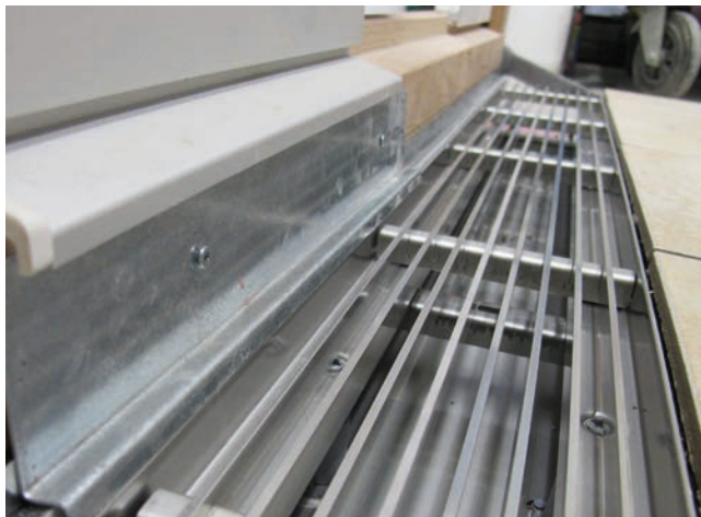
8 Dla ochrony uszczelnienia i estetycznego wykończenia połączenia ościeżnicy z odwodnieniem liniowym (ACO) zamontowano odpowiednią listwę z blachy.
