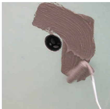
1 Naniesienie materiału uszczelniającego.
