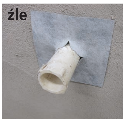
Uszczelka została nacięta, aby można ją było założyć na rurę.
