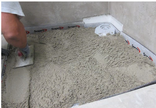
1 Przygotowanie korpusu odwodnienia narożnego i wbudowanie w jastryż wykonany z Sopro Rapidur® M5.
