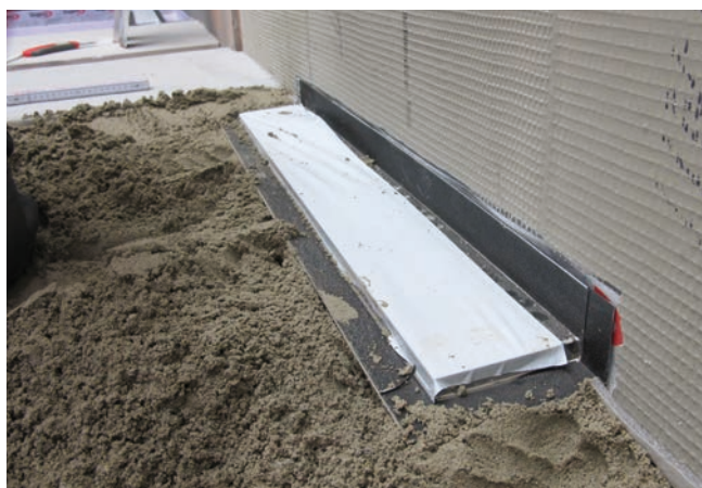
2 Osadzenie odwodnienia liniowego w świeżej warstwie jastrychu Sopro Rapidur® M5.
