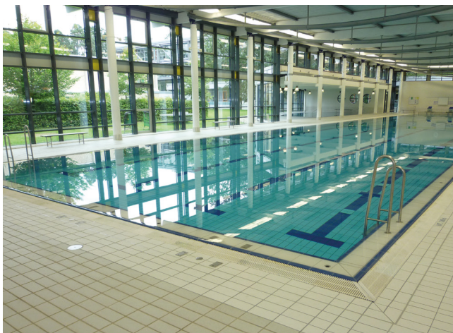
Wysokowytrzymała, cementowa zaprawa fugowa wraz z okładziną ceramiczną w nieszce basenowej.
