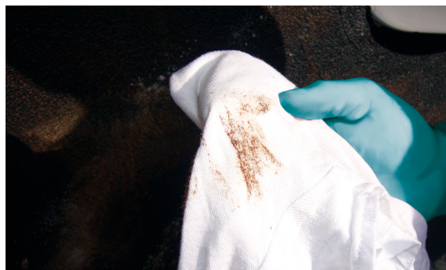
Zabarwienie o barwie brązowej: uszczelniona powierzchnia rozpuszcza się, tzn. z dużym prawdopodobieństwem jest to powłoka bitumiczna. Po oczyszczeniu (usunięcie zabrudzeń i ziemi) powierzchnię można poddać renowacji bitumiczną masą uszczelniającą np. Sopro KSP 652 lub Sopro KD 754.
