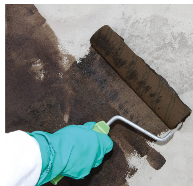
6 Powierzchnie przygotowane do uszczelnienia, po dokładnym oczyszczeniu, wymagają zagruntowania podkładem bitumicznym Sopro KDG 751.
