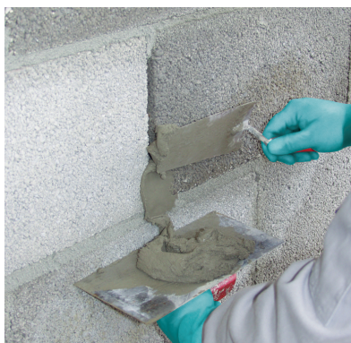
3 Niewystarczająco wypełnione spoiny i zagłębienia (> 5 mm) wypełnić zaprawą szpachlową Sopro RAM 3 ® lub Sopro AMT 468.
