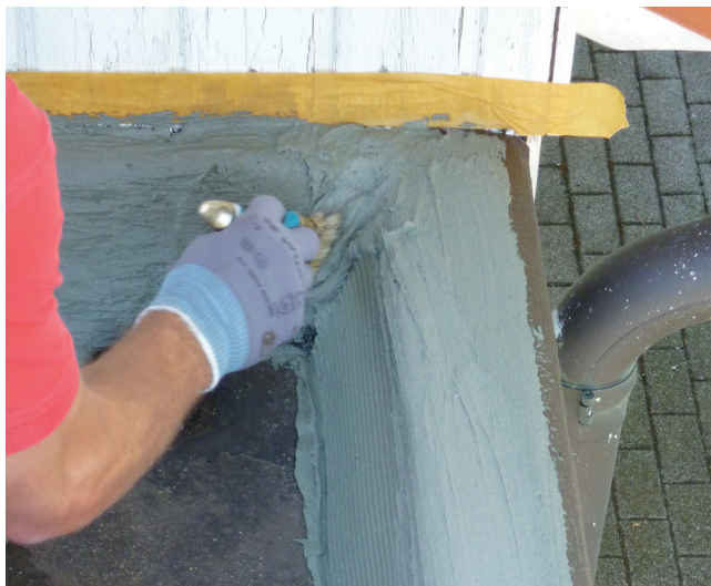
Uszczelnienie betonowej attyki na dachu.
