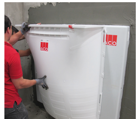
24 Po zakończeniu prac uszczelniających nakłada się systemową osłonę doświetlacza.
