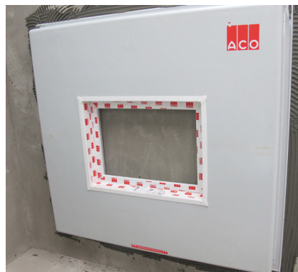
20 Skutecznie wykonana hydroizolacja ścian piwnic, to także wykonanie izolacji złączy np. przy naświetlach okien piwnicznych.
