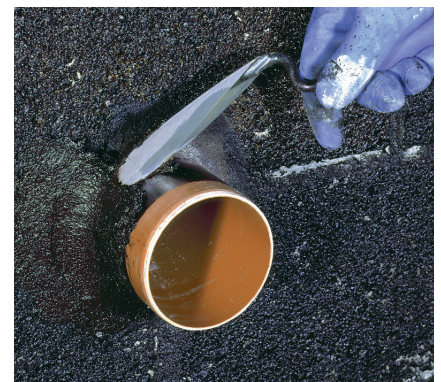
4 Po wyschnięciu podkładu, nałożyć bitumiczną masę uszczelniającą Sopro KSP 652, Sopro KD 754 lub Sopro KMB 651 w co najmniej dwóch warstwach.
