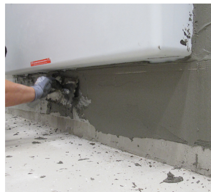
23 Uszczelnienie elementu systemowego wykonane wzdłuż jego całego obwodu, z zatopieniem siatki zbrojącej.
