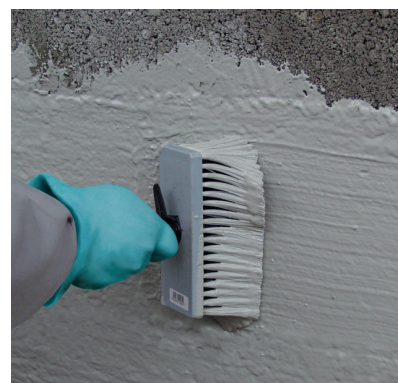
4 W obszarze cokołu oraz płyty fundamentowej, dla zabezpieczenia warstwy bitumicznej przed uszkodzeniem na skutek ewentualnego pojawienia się parcia negatywnego wody, zaleca się nałożenie najpierw powłoki z elastycznej zaprawy uszczelniającej Sopro ZR Turbo 618 lub Sopro TDS 823.
