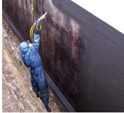
17 Natryskiwanie uszczelnienia bitumicznego.
