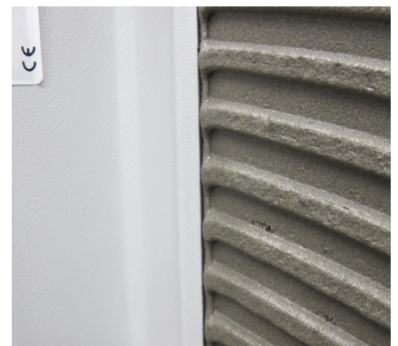
21 Elementy systemowe naświetli piwnicznych w sposób wodoszczelny zamocowane do zaizolowanej ściany piwnicy – przy użyciu Sopro TDS 823 lub Sopro ZR Turbo 618.
