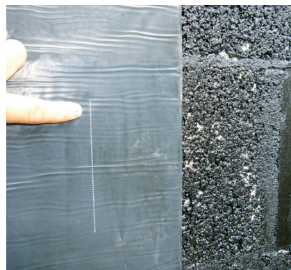
15 Nadrukowana linia kontrolna do klejenia na zakład – ułatwia montaż kolejnych arkuszy samoprzylepnej izolacji bitumicznej SoproThene® 878.
