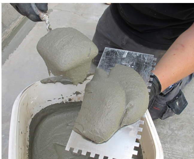
Sopro ZR Turbo 618 obficie nałożony na pacę pozwala na grubowarstwowe przeszpachlowanie nierówności podłoża.
