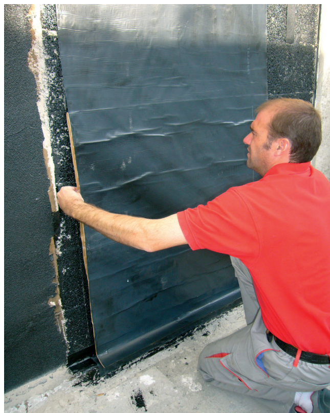
Uszczelnienie piwnicy samoprzylepną izolacją bitumiczną SoproThene®, zgodne z wymogami normy DIN 18533.
