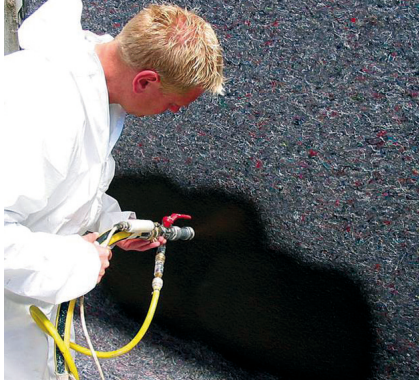
16 Aplikacja masy bitumicznej Sopro KSP 652 metodą natryskową z użyciem pompy Inomat.
