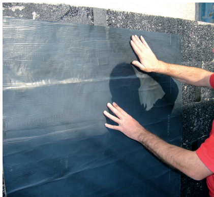
10 Wyrównać i docisnąć do podłoża początek przyklejanego arkusza izolacji bitumicznej SoproThene® 878.
