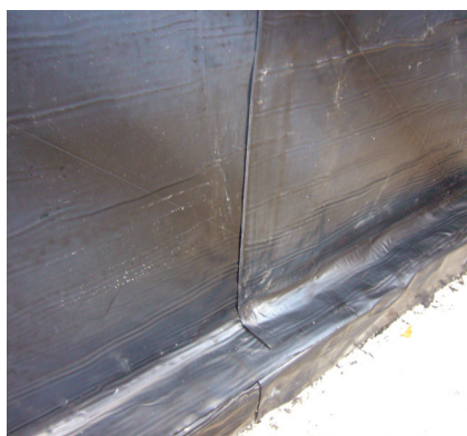
17 Wykonane uszczelnienie samoprzylepne na połączeniu ściany piwnicy z płytą/ławą fundamentową.
