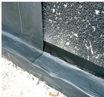
14 Niezbędne, prawidłowe zabezpieczenie styku dzięki zastosowaniu taśmy dwustronnej SoproThene® 87808.
