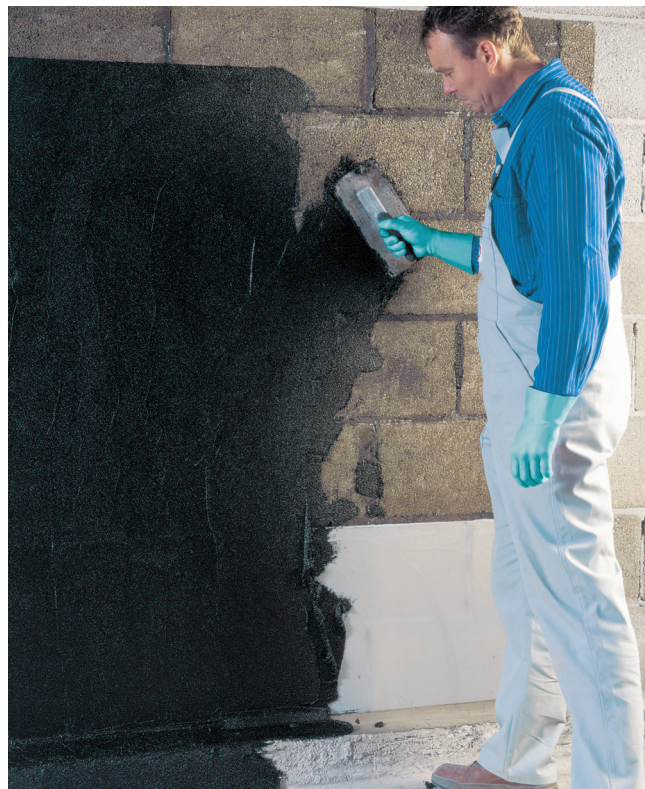
Nakładanie bitumicznego uszczelnienia grubowarstwowego.
