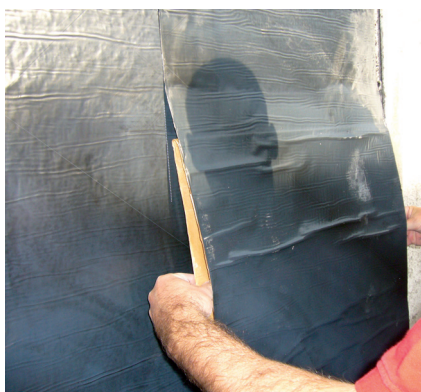
16 Przyklejanie następnego arkusza izolacji bitumicznej SoproThene® 878.
