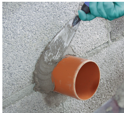
1 Przy użyciu szpachli Sopro RAM 3® wykonać wyoblenia.
