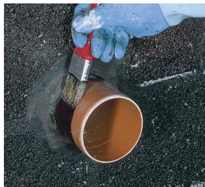
3 Dla zwiększenia przyczepności bitumicznej masy uszczelniającej, zastosować bitumiczny podkład gruntujący Sopro KDG 751.
