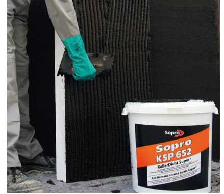
18 Po wyschnięciu, na uszczelnienie zostają przyklejone odpowiednie maty drenażowe, np. Sopro KDS 663 lub płyty izolacyjne. W tym przypadku Sopro KSP 652 nakładana jest pełno-powierzchniowo na spód płyty termoizolacyjnej.
