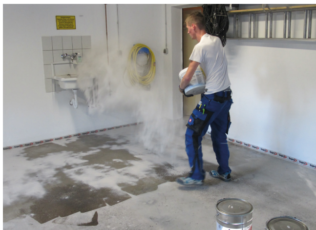
Podkład epoksydowy Sopro EPG 1522 obsypać obficie piaskiem kwarcowym Sopro QS 511.
