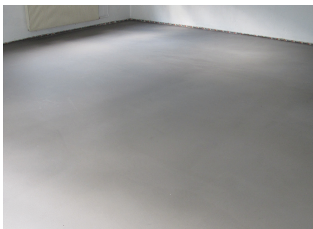
Już po kilku godzinach masa szpachlowa jest związana i możliwe jest chodzenie po niej.
