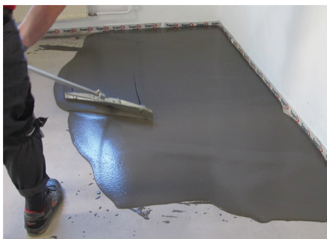
Sopro ambiente® floor wylać na podłogę i równomiernie rozprowadzić na przygotowanym podłożu przy pomocy rakli.
