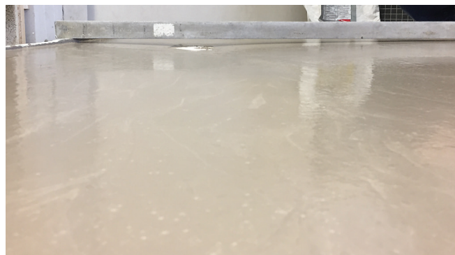
Powierzchnia ze spadkiem, wytworzona z Sopro FLOOR WS 3.70 extreme.
