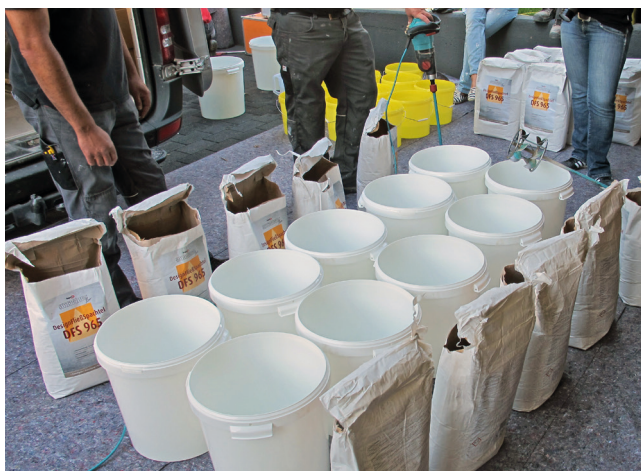
Przygotować materiał poprzez wymieszanie z odpowiednią ilością wody zarobowej.
