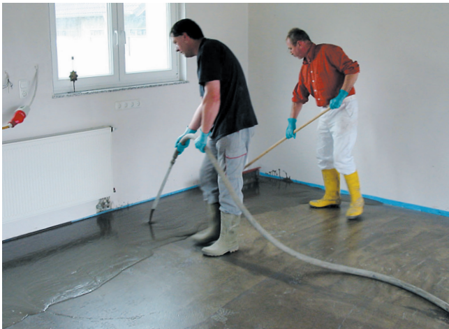
Łatwe nanoszenie masy samopoziomującej Sopro HF-S przy pomocy agregatu.
