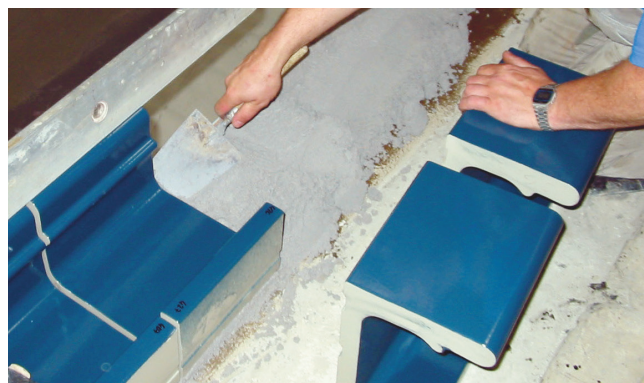
Układanie kształtek basenowych na zaprawie epoksydowej Sopro EE 771.
