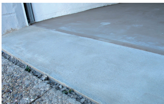
Wyrównana powierzchnia ze spadkiem, podjazd do garażu.
