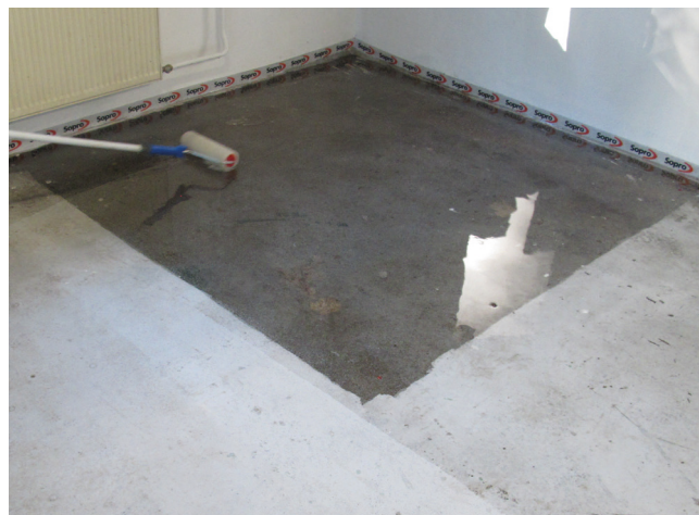
Zagruntować powierzchnię epoksydowym podkładem Sopro EPG 1522.
