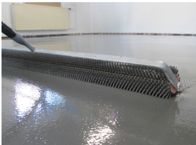
Dla rozprowadzenia i zagęszczenia ambiente® floor obrobić walcem kolczatym.
