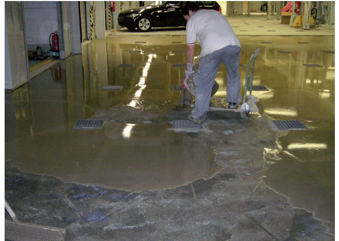
Zastosowanie szybkowiążącej masy samopoziomującej Sopro FS 15® plus do wyrównania posadzki, przed klejeniem płyt wielkoformatowych.
