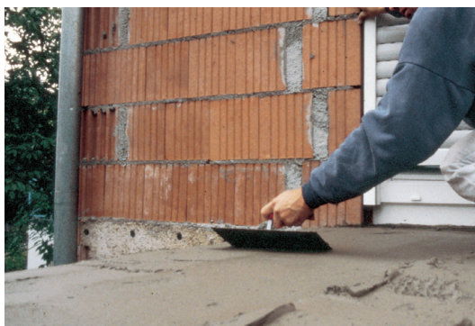
Wykonanie wymaganego spadku na balkonie szpachlą wyrównawczą Sopro RAM 3® lub Sopro AMT 468.
