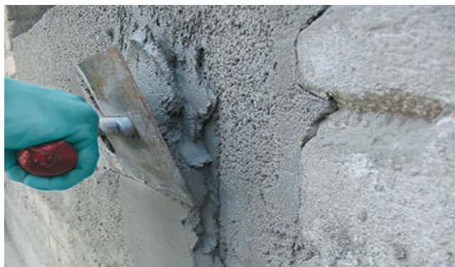
Mur wyrównany szpachlą Sopro RAM 3® pod następnie przyklejane płytki metodą cienkowarstwową.
