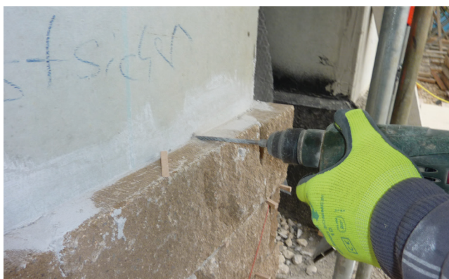
Wywiercenie otworów dla mechanicznego zakotwienia warstwy elewacyjnej kotwami z prętów stalowych.
