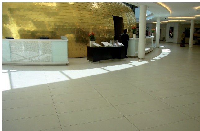
Płyty wielkoformatowe ułożone na posadzce w holu wejściowym.
