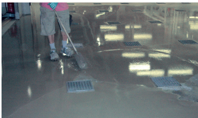
Zastosowanie wylewki samopoziomującej Sopro FS 15 ® plus do wyrównania powierzchni.
