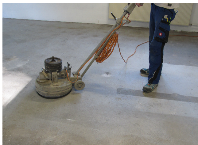
Szlifowanie jastrychu anhydrytowego jako ważny element obróbki przed montażem okładzin ceramicznych.
