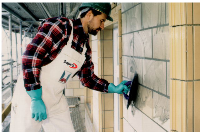
Spoinowanie zaprawą fugową, hydraulicznie wiążącą.
