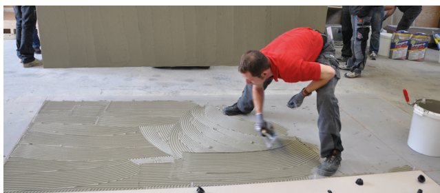
Naniesienie zaprawy klejowej na spód płyty i na podłoże.
