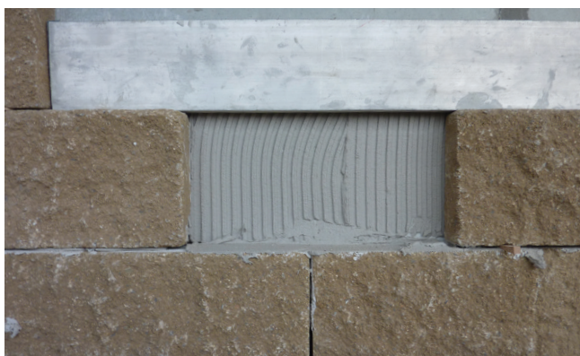
Osadzenie płytek elewacyjnych na betonowym podłożu z zastosowaniem Sopro FKM® Silver metodą kombinowaną.
