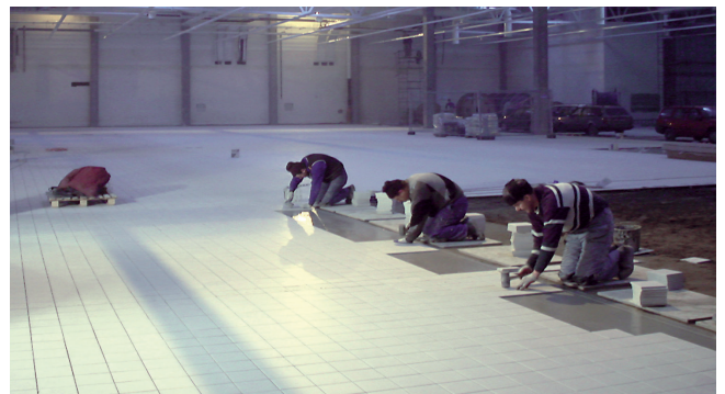
Układanie okładziny ceramicznej na świeżej warstwie zaprawy szcpej.
