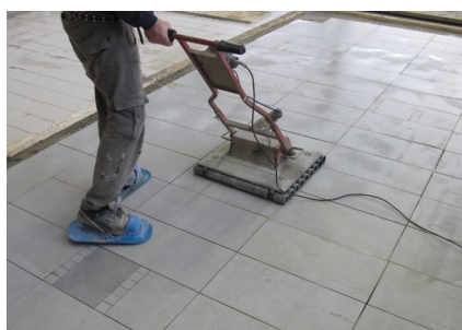
Wibrowanie świeżo ułożonej okładziny ceramicznej.
