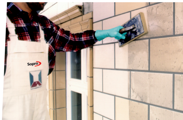
Zmywanie zafugowanej powierzchni.
