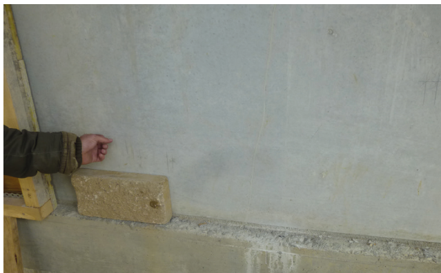
Powierzchnia do montażu na betonowej płycie fundamentowej.
