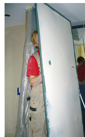
Wielkoformatowa płyta szklana układana na kleju poliuretanowym Sopro PUK 503.
