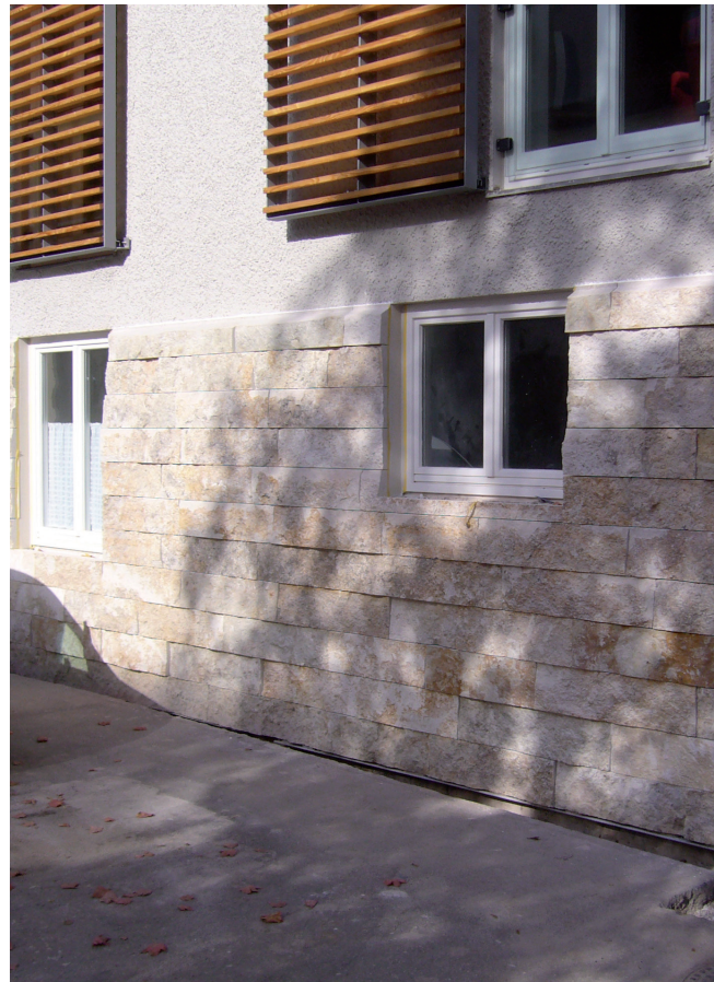
Lico ściany wykonane z elementów kamiennych.
