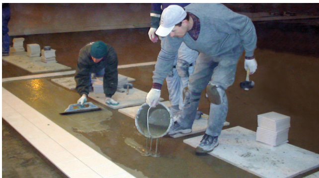
Nanoszenie zaprawy szcpej na przygotowaną zaprawę grubowarstwową.
