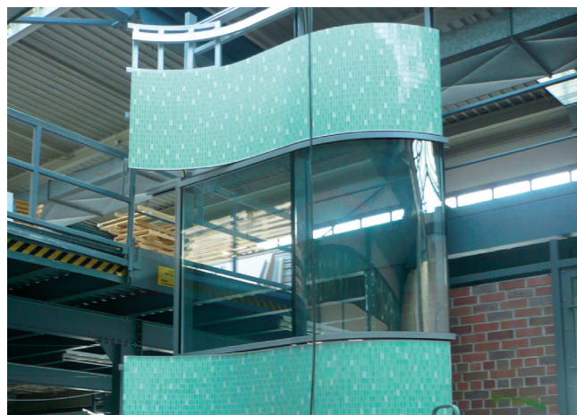
Ułożenie mozaiki szklanej na płycie nośnej dla obudowy elewacji.
