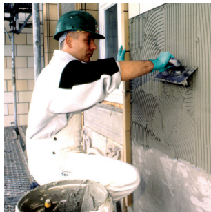
Metoda kombinowana – nałożenie warstwy kontaktowej i grzebieniowej na podłoże.
