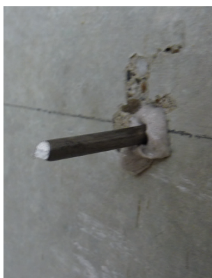
Osadzona kotwa drutowa dla mechanicznego mocowania.
