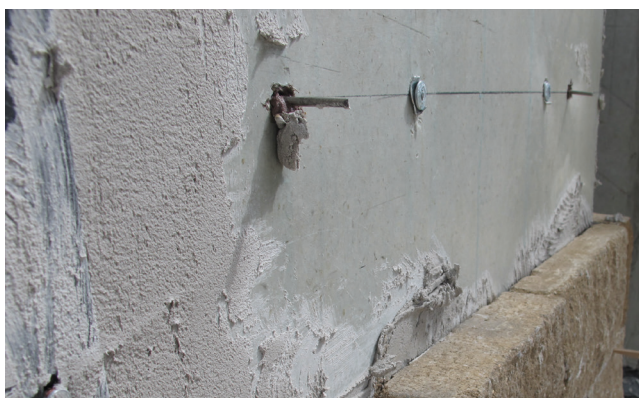
Kotwy zostały odpowiednio rozmieszczone na każdym m 2 powierzchni.
