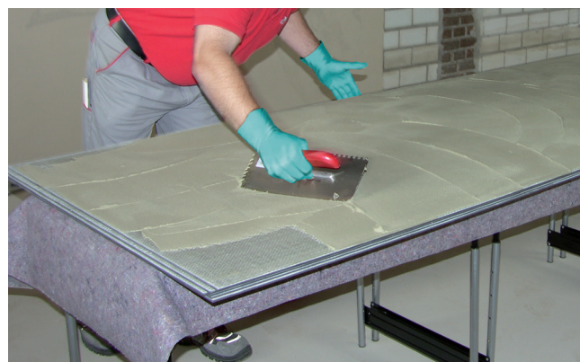
Odpowiednie wyposażenie miejsca pracy jest niezbędne do właściwego montażu płyt wielkoformatowych.
