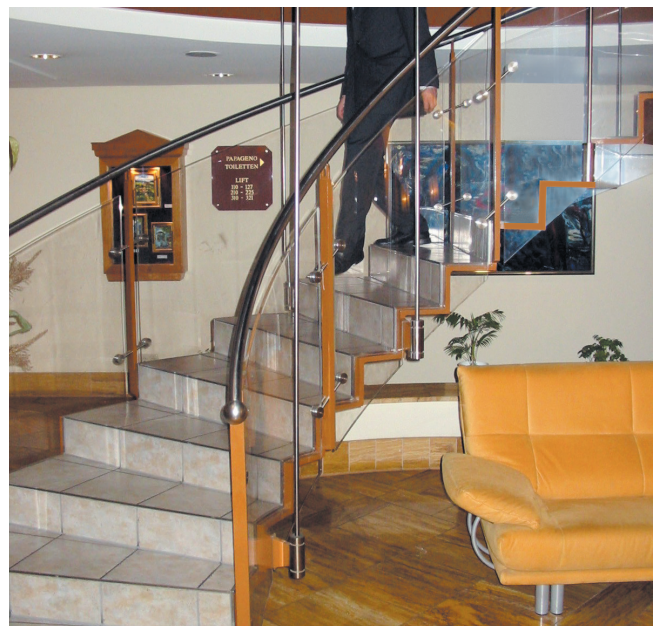
Ze względu na występujące drgania konstrukcji schodów stalowych, zaprawa klejowa powinna posiadać wysoką zdolność kompensacji naprężeń.
