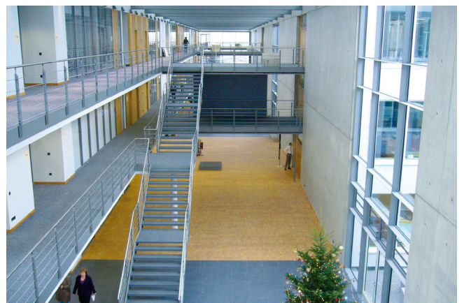
Smukła konstrukcja schodów stalowych, przebiegająca przez kilka pięter. Stopnie i podesty obłożone okładziną z kamienia naturalnego.
