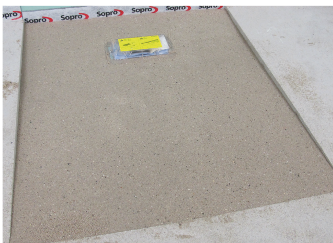
Wbudowanie jastrychu epoksydowego na posadce natrysku w cienkiej warstwie.
