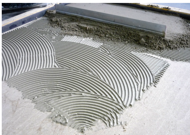
Wysokoelastyczna zaprawa klejowa pozwala na wytworzenie odpowiedniego podkładu przyczepnego pod jastrych, metodą „mokre a mokre”.
