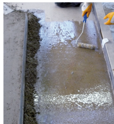
Epoksydowy podkład przyczepny pod jastrych zespolony.
