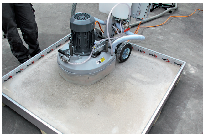
Po utwardzeniu jastrych Sopro Rapidur® FE może być obrabiony przy pomocy konwencjonalnej szlifierki.
