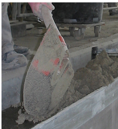
Nakładanie zaprawy jastrychowej Sopro Rapidur® M5 metodą „mokre na mokre” na zalecany preparat gruntujący Sopro EPG 1522.
