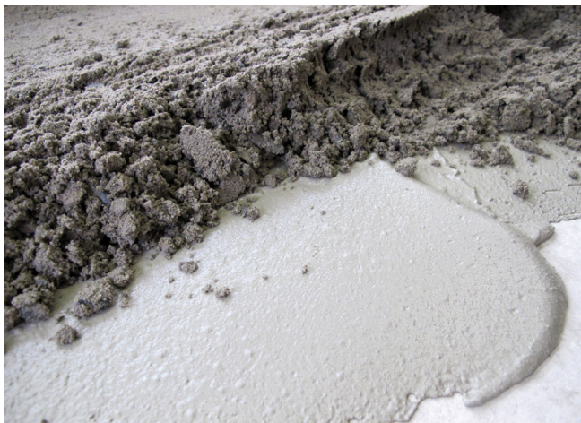
Świeża zaprawa jastrychowa nałożona na świeży podkład przyczepny Sopro HSF 748, czyli metodą „mokre na mokre”.
