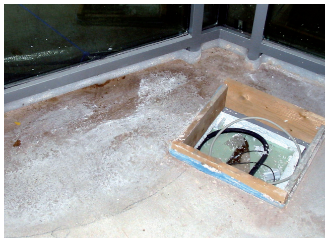
Problemy z odpornością i zjawiskiem rozpuszczania się jastrychu anhydrytowego na skutek wystąpienia wody.
