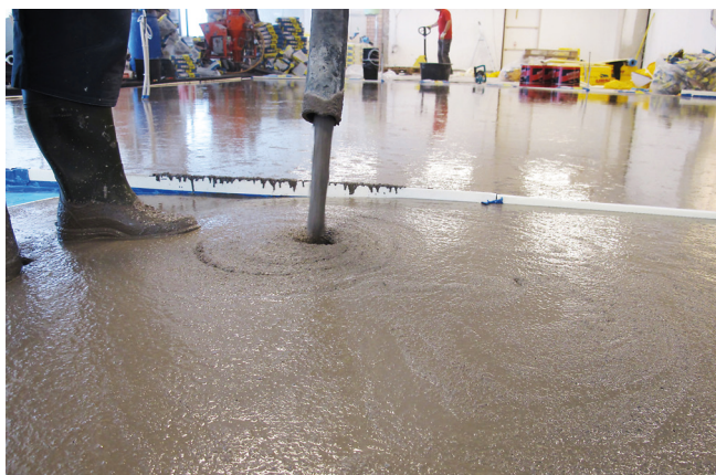
Wylanie Sopro Rapidur® FE – cementowego jastrychu płynnego.
