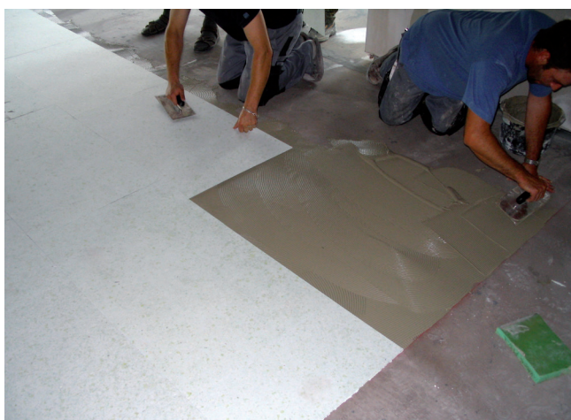
Układanie płyt kompensujących przy użyciu wysokoelastycznej zaprawy klejowej na konstrukcji podłogi podniesionej.
