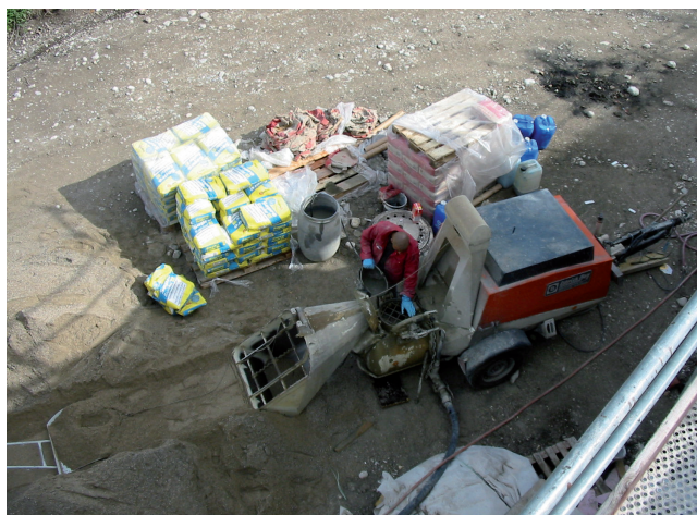
Wykonanie jastrychu cementowego przy pomocy pompy.
