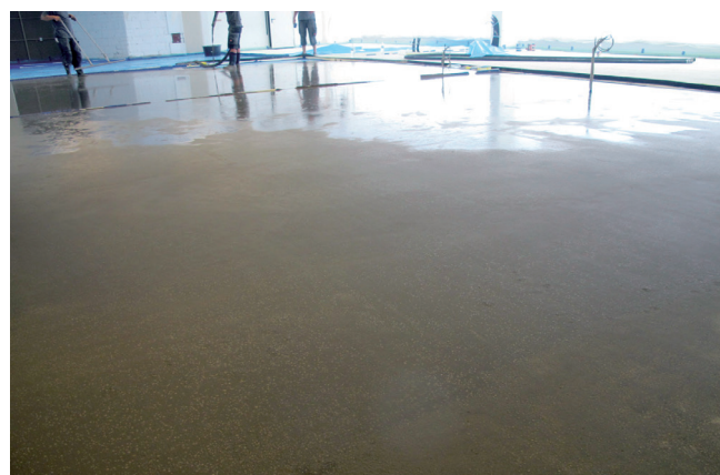
Sopro Rapidur® FE to szybkowiążący i szybko dojrzewający jastrych o równej, gładkiej powierzchni, który umożliwia przyklejanie na nim okładzin wielkoformatowych bez dodatkowego wyrównywania podłoża.
