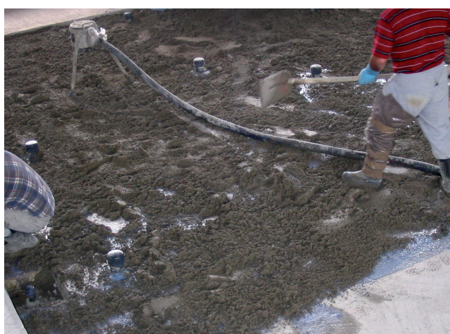
Jastrych cementowy przygotowany w konsystencji wilgotnej ziemi.
