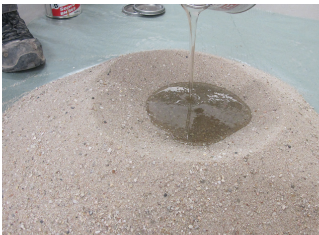
Jastrych na bazie żywicy epoksydowej powstaje z suchego piasku kwarcowego i żywicy budowlanej (Sopro BH 869 + Sopro EEK 871).
