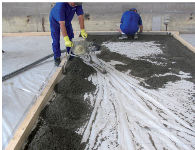
Zaprawa jastrychowa naniesiona na warstwę oddzielającą z folii. Po zagęszczeniu wykonany jastrych nie będzie połączony z podłożem.
