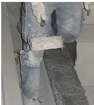
Nakładanie podkładu epoksydowego Sopro EPG 1522 jako mostka szcpeznego pod zaprawę jastrychową.
