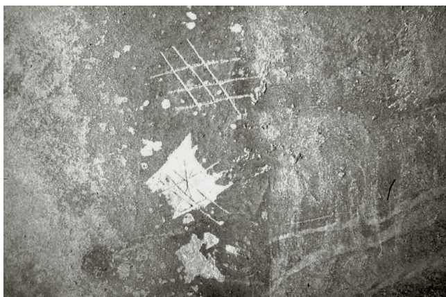
Ocena nośności powierzchni poprzez wykonanie testu na zarysowanie.
