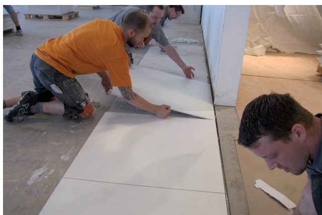
Kilka godzin po wbudowaniu cementowego, szybkowiążącego jastrychu płynnego Sopro Rapidur® FE możliwe jest układanie okładzin wielkoformatowych metodą cienkowarstwową, bez konieczności dodatkowego wyrównywania powierzchni.
