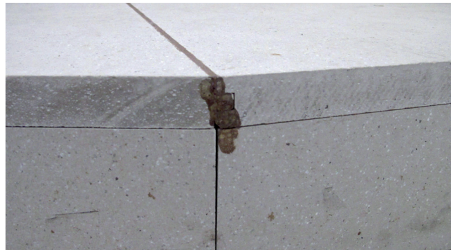
Sucha podłoga podniesiona w obszarze schodów.
