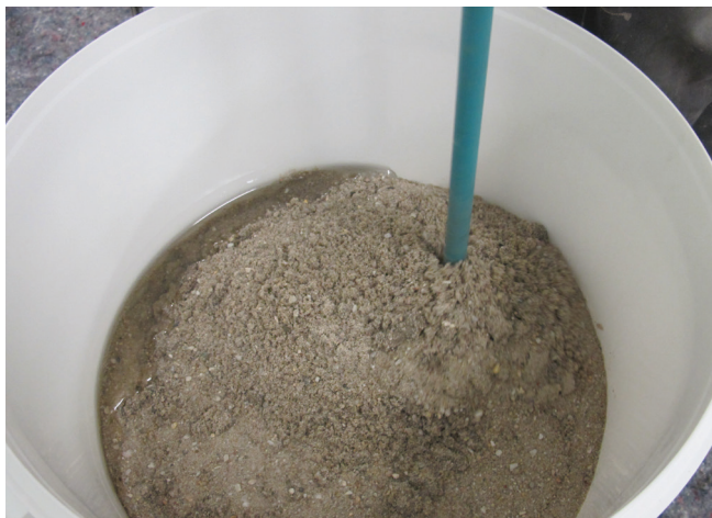
Mieszanie jastrychu epoksydowego na jednolitą masę.
