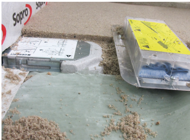
Posadzka natrysku wykonana z zastosowaniem jastrychu epoksydowego.
