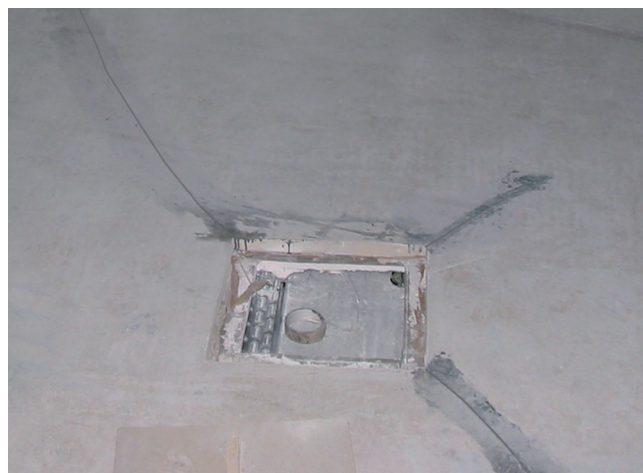
Rysy skurczowe na jastrychu anhydrytowym powstałe podczas jego wysychania.
