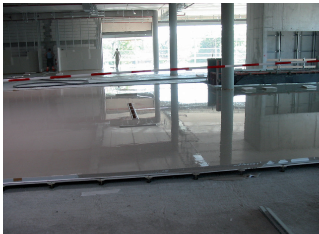
Płynny jastrych anhydrytowy wykonany na podniesionej konstrukcji podłogowej.
