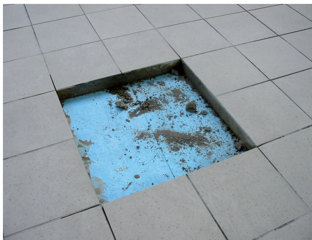
Jastrych pokryty płytkami, wykonany na warstwie izolacji termicznej.
