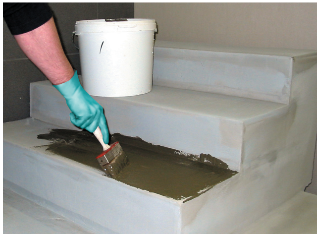
2 Naniesienie podkładu przyczepnego, elastycznego z trasem Sopro HSF 748 na uszczelnienie zespolone jako warstwy kontaktowej dla zaprawy drenażowej Sopro DM 610.
