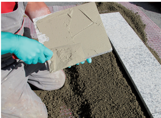
3 Naniesienie zaprawy kontaktowej Sopro HSF 748 na spód płyty kamiennej.
