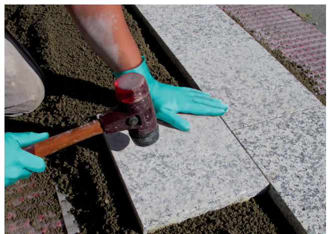
4 Ułożenie płyty kamiennej na warstwie drenażowej zaprawy grubowarstwowej, dobicie gumowym młotkiem.
