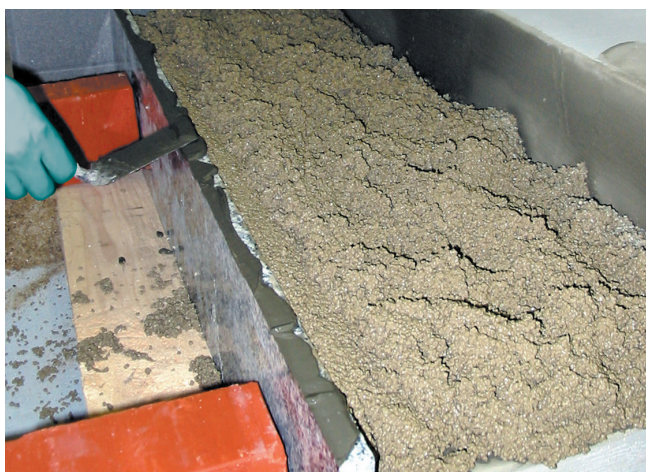
5 Warstwa zaprawy drenażowej przygotowana do osadzenia stopnicy.
