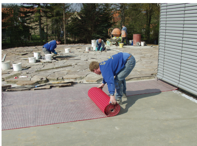
Rozwinięcie maty drenażowej na uszczelnieniu zespolonym pod układany kamień naturalny na zaprawie drenażowej.
