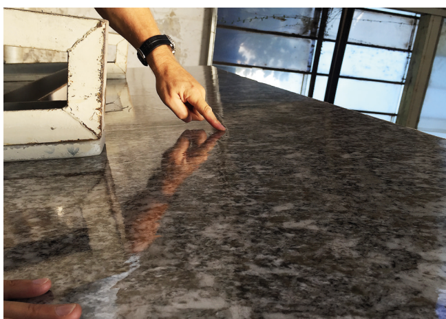
Powierzchnia płyty kamiennej pokryta żywicą dla zamknięcia rys.
