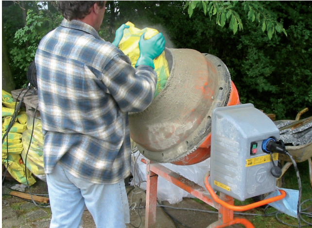
1 Przygotowanie zaprawy drenażowej Sopro DM 610 w betoniarce wolnospadowej.
