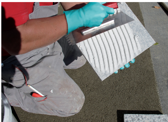
5 Naniesienie zaprawy klejowej cienkowarstwowej na spód płytki kamiennej.
