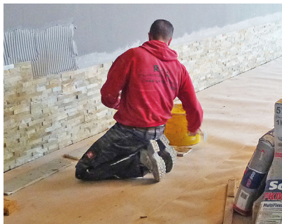
Układanie płytek z kamienia naturalnego na ścianie metodą kombinowaną.
