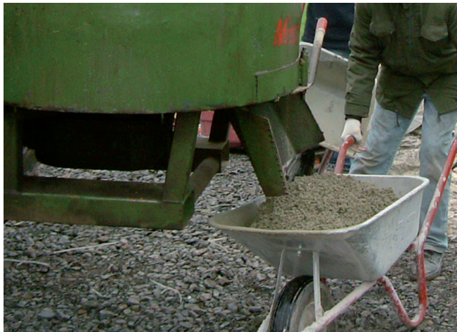
1 Mieszanie zaprawy drenażowej w betoniarce przeciwbieżnej lub pompą do jastrychów.
