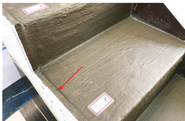
Bieg schodów z przygotowaną, ukształtowaną krawędzią.
