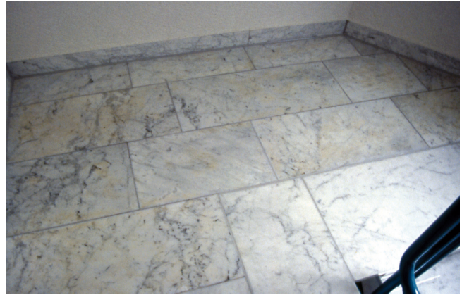
Żółte przebarwienia na okładzinie, wywołane przez występujące w kamieniu związki żelaza, które mogą się uaktywnić pod wpływem wilgoci, pochodzącej z zaprawy grubowarstwowej.
