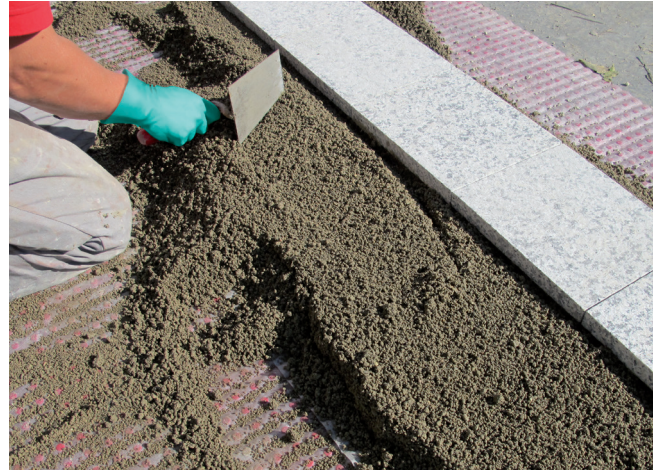
2 Wyłożenie i rozprowadzenie zaprawy drenażowej Sopro DM 610 do układania płyt kamiennych metodą „mokre na mokre”.
