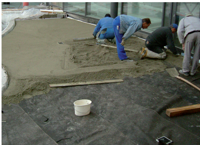
3 Wykonanie warstwy drenażowej Sopro DM 610 jako jastrych o jednakowej grubości (zapewnia prawidłowy rozkład obciążeń).
