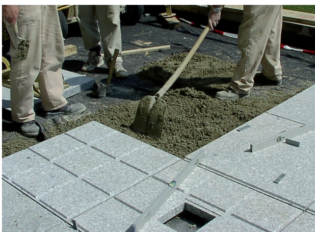
5 Rozkładanie zaprawy drenażowej Sopro DM 610 pod płyty wielkoformatowe, układane metodą grubowarstwową.
