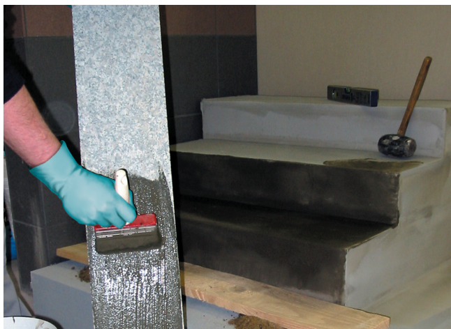
3 Przygotowanie okładziny do osadzenia poprzez naniesienie na jej spodnią stronę podkładu przyczepnego Sopro HSF 748.
