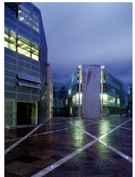
Kamień naturalny zastosowany na zewnątrz.
