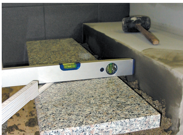
6 Gotowy stopień, ułożony na zaprawie drenażowej Sopro DM 610.
