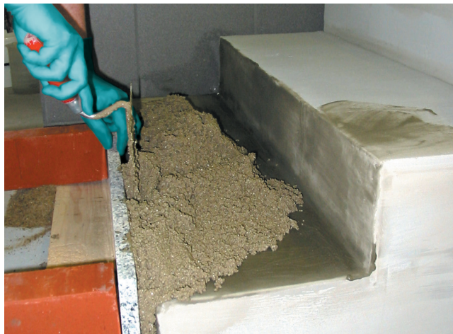
4 Osadzenie podstopnicy na zaprawie drenażowej Sopro DM 610.
