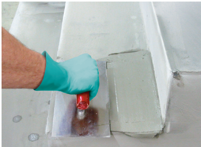
1 Ukształtowanie spadku na stopniach przy pomocy szpachli Sopro RAM® 3.
