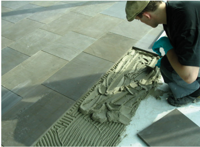
Układanie kamienia naturalnego metodą średniowarstwową na zaprawie Sopro TR 414.
