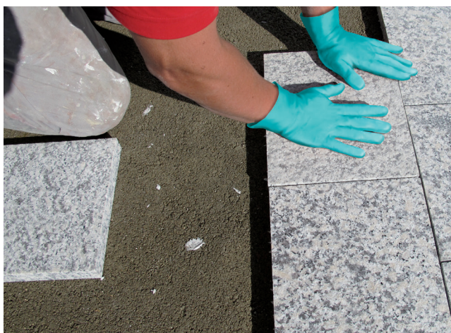
6 Układanie płytek kamiennych (z naniesioną warstwą zaprawy klejowej cienkowarstwowej) na związanym jastrychu drenażowym, warstwie rozdzielającej obciążenia.
