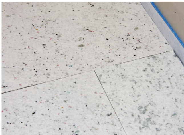
13 Układanie płyt następuje bezspoinowo, krawędzie płyt przylegają do siebie.
