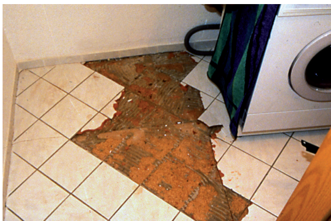
Pęknięcia w okładzinie i odspojenia w obszarze styku z płytą wiórową, spowodowane przez drgania (np. pralki).
