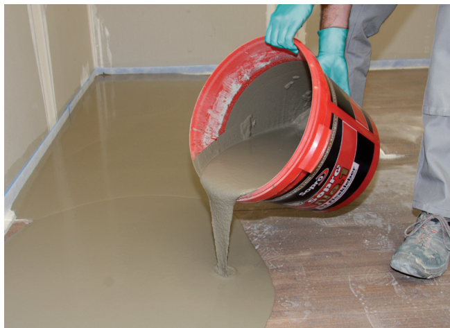
7 Wyrównanie nierówności za pomocą elastycznej, wzmocnionej włóknami wylewki samopoziomującej Sopro FLOOR WS 3.70 extreme.
