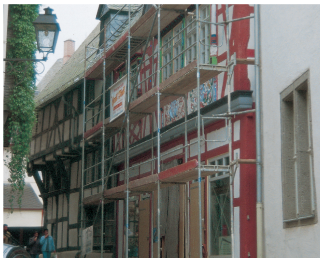
Remont zabytkowego budynku.
