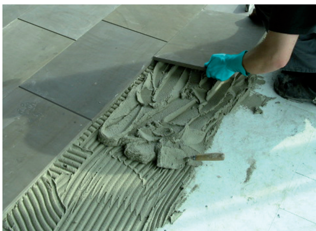
3 Układanie okładziny z kamienia naturalnego metodą średnio-warstwową przy użyciu wysokoelastycznej zaprawy klejowej z trasem Sopro TR 414.
