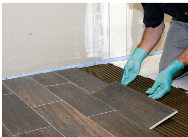
16 Układanie płytek ceramicznych w przygotowanej warstwie zaprawy klejowej Sopro FKM® XL.
