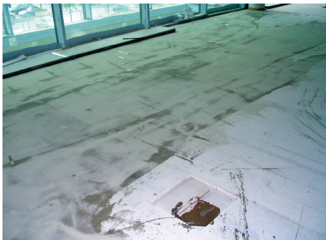
1 Gruntowanie podłoża chłonnego.
