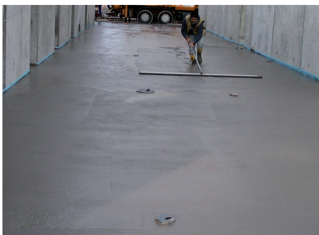
Świeży beton w terminalu lotniczym.
