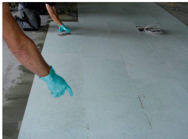
2 Układanie płyt kompensacyjnych Sopro FDP 558, odprężających okładzinę wierzchnią (kamień naturalny) od podłoża.
