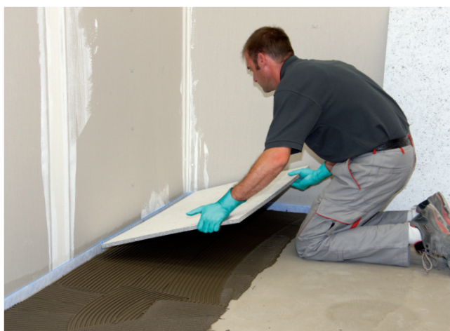
10 Układanie płyt kompensacyjnych Sopro FDP 558 ( \geq 7 mm) na zaprawie klejowej.
