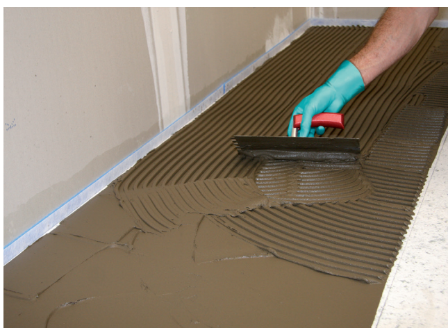
15 Na płyty kompensacyjne Sopro FDP 558 do układania okładziny ceramicznej nanieść zaprawę klejową, np. Sopro FKM® XL.
