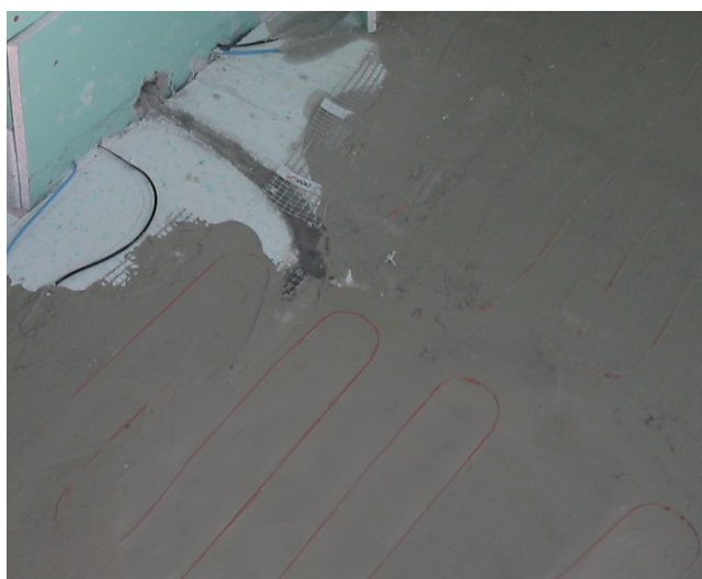
Elektryczna mata grzewcza zatopiona w zaprawie klejowej Sopro No.1 400 extra.
