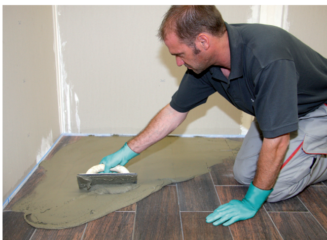
17 Spoinowanie okładziny ceramicznej fugą elastyczną Sopro FL plus lub Sopro DF 10®.
