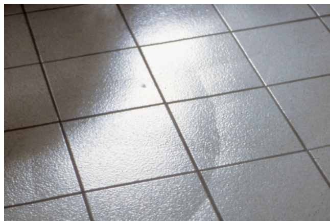
Pęknięcia i uszkodzenia płytek, spowodowane ich ułożeniem bezpośrednio na podłożu z desek drewnianych.
