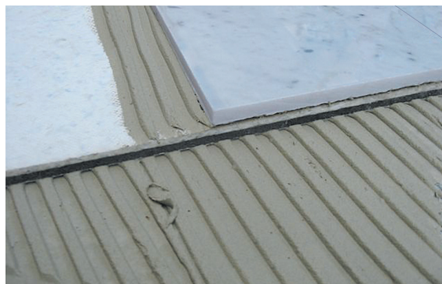
Płyty FDP 558 ułożone na podeście schodów jako wygłuszenie pod okładziną z kamienia naturalnego.
