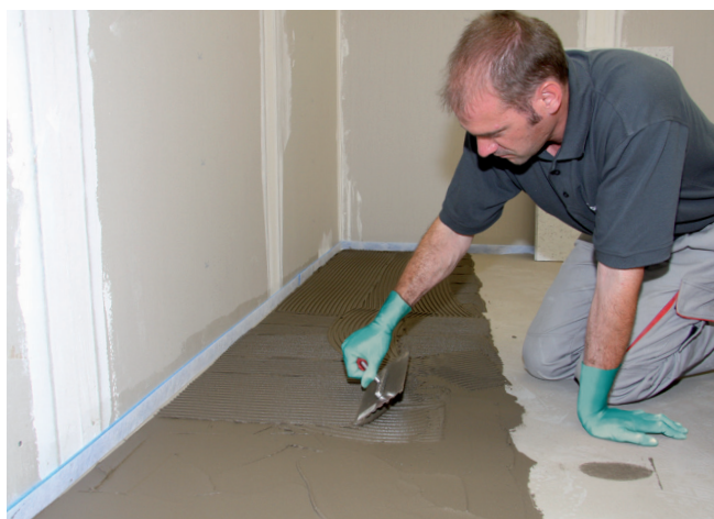
9 Jeśli podłóże drewniane jest równe, bezpośrednio na podkład gruntujący Sopro HPS 673 nałożyć zaprawę np. Sopro FKM® XL w celu przygotowania powierzchni pod płyty kompensacyjne Sopro FDP 558.
