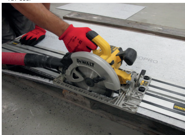
11 Obróbka i ciecie płyt kompensacyjnych Sopro FDP 558 jest możliwe np. przy użyciu pilarki elektrycznej.
