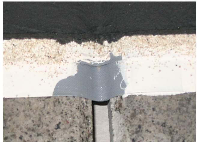
Uszczelnianie szczeliny dylatacyjnej niecki basenowej dwuwarstwowo taśmą uszczelniającą, zatopioną w elastycznej powłoce uszczelniającej Sopro PU-FD.
