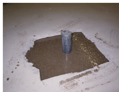
Wypełnienie antykapilarne przepustu mieszanką epoksydowo-piaskową (Sopro EPG 1522 zmieszane z Sopro QS 507 i Sopro QS 511 w proporcji 1:1:1).
