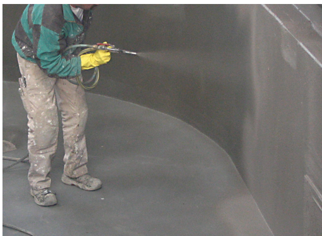
1 Nakładanie elastycznej zaprawy uszczelniającej Sopro DSF® 423/523 w co najmniej dwóch warstwach, metodą natryskową.
