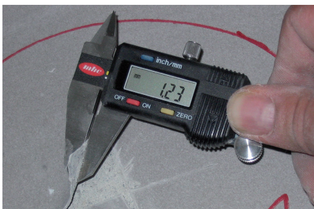
11 Sprawdzenie grubości wykonanego uszczelnienia zespolonego.
