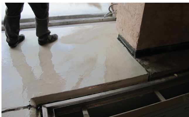
3 Zagruntowanie powierzchni żywicą Sopro EPG 1522 i obsypanie piaskiem kwarcowym Sopro QS 507.
