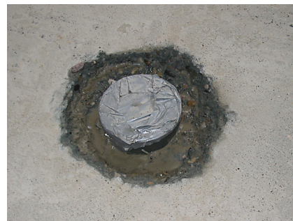
Wykonane zagłębienie pod wypełnienie epoksydową zaprawą antykapilarną.
