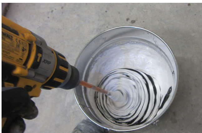
9 Farba kontrastowa Sopro PU-FD KF 572 mieszana z Sopro PU-FD – uszczelnienie uzyskuje szarą barwę.
