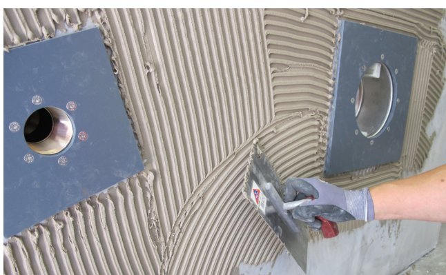
5 Nałożenie na betonową ścianę wysokoelastycznej zaprawy klejowej Sopro No.1 400 extra jako warstwy kontaktowej pod następnie nakładany tynk Sopro RAM 3®.
