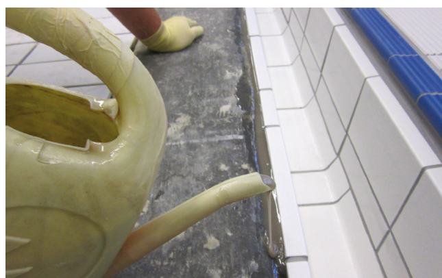
Wykonanie fugi antykapilarnej przy użyciu preparatu epoksydowego Sopro EPG 1522 oraz piasku kwarcowego Sopro QS 511 i Sopro QS 507, zmieszanych w proporcji 1:1:1 objętościowo.
