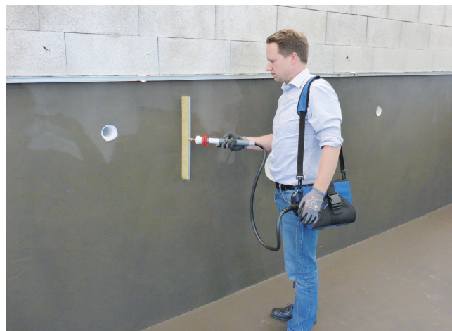
Urządzenie pomiarowe pozwala na szybką lokalizację nieszczelności w powłoce uszczelnienia.
