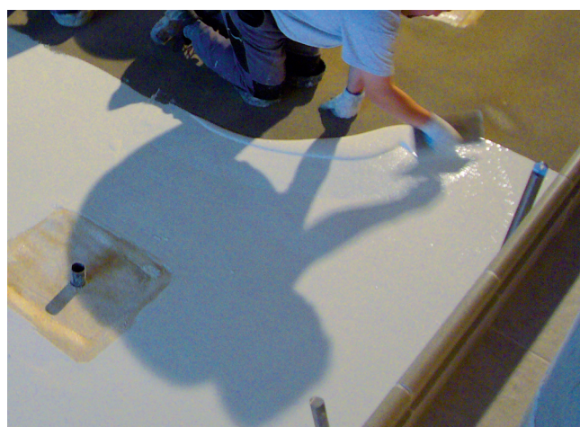
6 Uszczelnienie powierzchni niecki basenowej przy użyciu elastycznej powłoki uszczelniającej Sopro PU-FD 1570.
