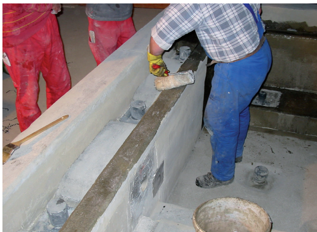
1 Gruntowanie powierzchni przy użyciu epoksydowego podkładu gruntującego Sopro EPG 1522. Zużycie zależy od chłonności podłoża.
