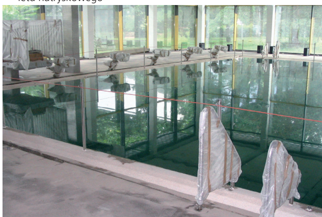
12 Próba wodna (trwa minimum 14 dni).
