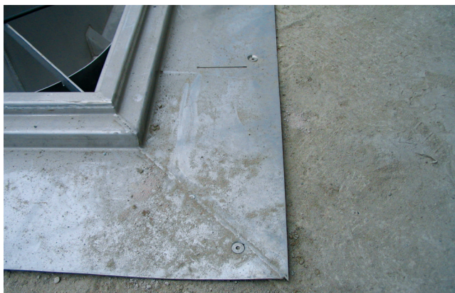
Niecka ze stali nierdzewnej z szerokim kołnierzem zakotwionym na płycie betonowej lub jastrychu zespolonym, na który można nanieść uszczelnienie zespolone.
