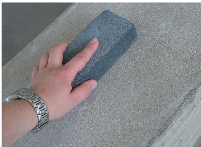
3 Obróbka suchej powierzchni z posypką z piasku kwarcowego przy użyciu kształtki korundowej.
