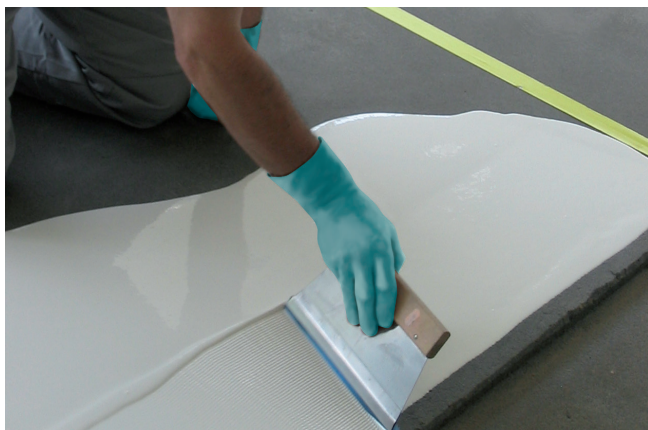
7 Uszczelnienie podłogi przy użyciu Sopro PU-FD 1571.
