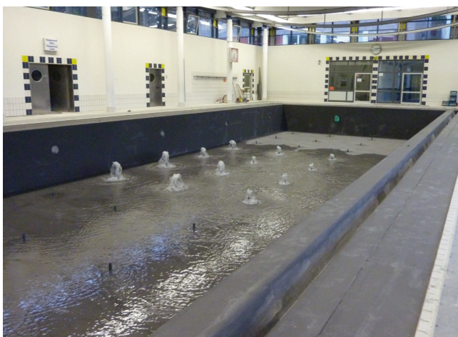
Po naniesieniu i wyschnięciu uszczelnienia zespolonego w niecce basenowej przeprowadzana jest próba wodna.
