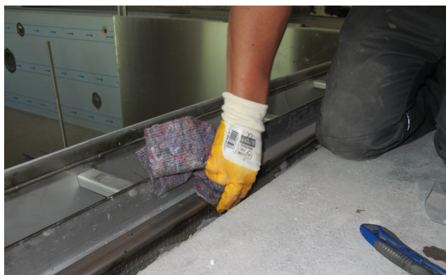
2 Dokładne oczyszczenie stalowego kołnierza, usunięcie plam z olejów, zatuszczeń itd.
