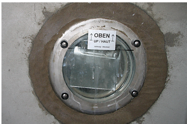
Obudowa reflektora zaszpachlowana antykapilarnie przy użyciu Sopro DBE 500.
