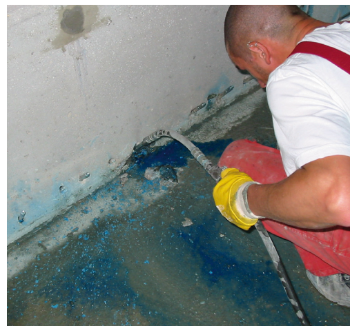
Wypełnianie rys w niecce z betonu wodoszczelnego.
