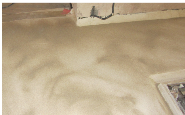
6 Uszczelniona powierzchnia wokół i na styku z niecką stalową. Uszczelnienie Sopro PU-FD z posypką z piasku kwarcowego Sopro QS, gotowe do następnych prac.
