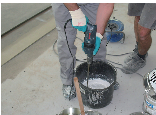
5 Dokładne wymieszanie elastycznej powłoki uszczelniającej Sopro PU-FD 1570.
