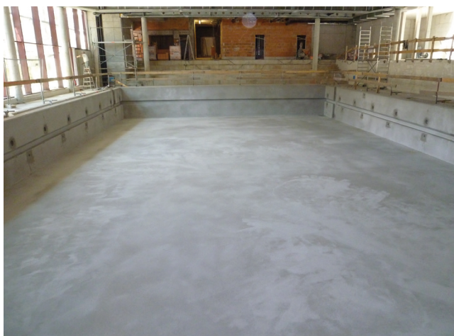
Nowo wykonana betonowa niecka basenowa musi być sezonowana minimum 6 miesięcy.
