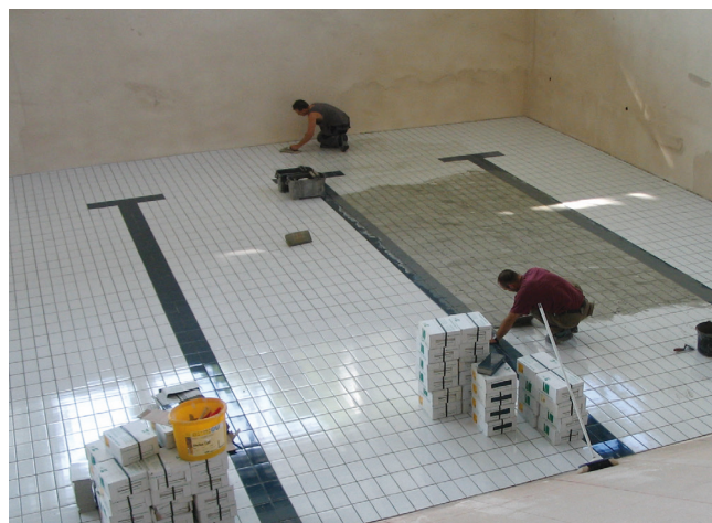
4 Fugowanie okładziny wysokowytrzymałą fugą Sopro TF+.
