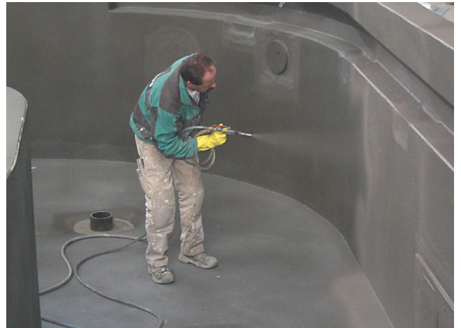
Aplikacja uszczelnienia zespolonego Sopro TDS 823 metodą natryskową.
