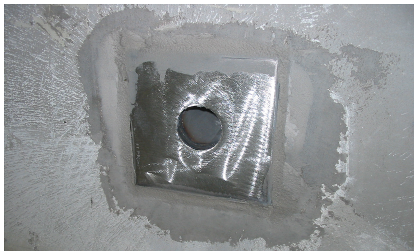
Kołnierz z zamkniętą tuleją, osadzony w nieszce basenowej, do montażu poręczy.
