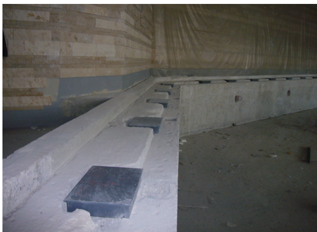
Zabetonowana w stanie surowym skrzynka odpływowa do późniejszego montażu rynny przelewowej.
