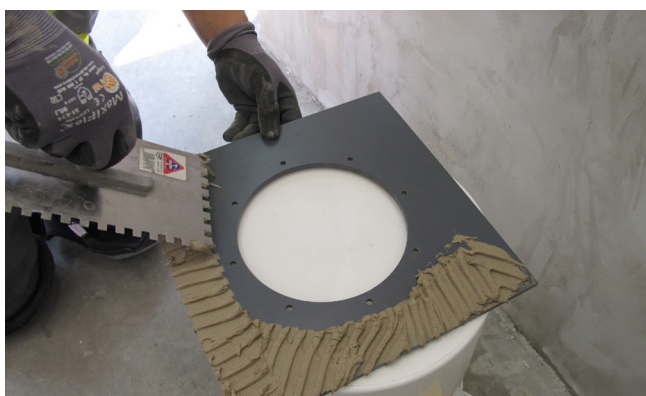
3 Spodnia część kołnierza pokryta zaprawą na bazie żywicy reaktywnej Sopro DBE 500, aby zapewnić szczelne i trwałe połączenie z podłożem betonowym.
