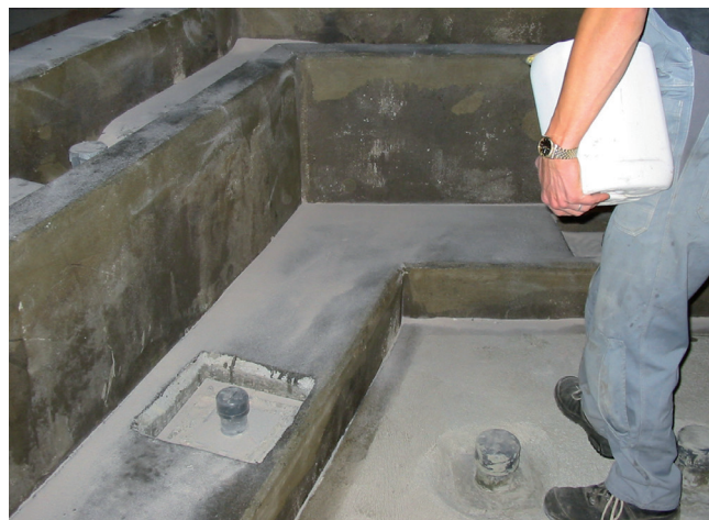
2 Wykonanie posypki z piasku kwarcowego Sopro QS 507 na świeżej warstwie podkładu epoksydowego Sopro EPG 1522.
