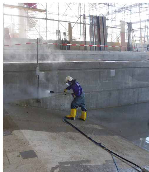
Czyszczenie powierzchni betonu metodą piaskowania lub wodą pod wysokim ciśnieniem.
