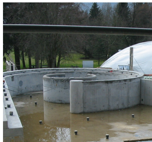
Bezpośrednio przed przystąpieniem do prac w surowej niecce nie powinna zalegać woda, ponieważ wysychając negatywnie wpływa na beton.
