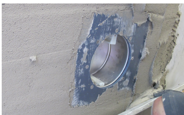
6 Profilowanie powierzchni i zlicowanie tynku z kołnierzem montażowym reflektora przy użyciu Sopro RAM 3®.
