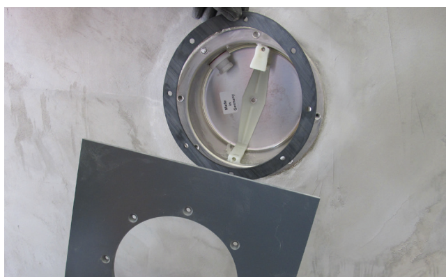
2 Kołnierz montażowy do zamontowania na miejscu budowy.
