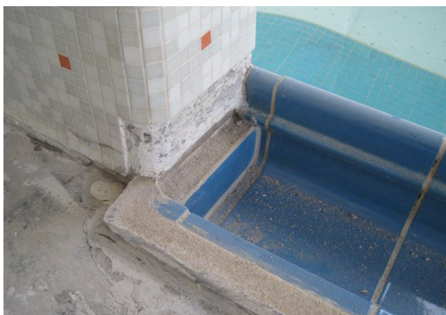
Doszczelniający korek epoksydowy na zakończeniach rynny przelewowej „Wiesbaden”.
