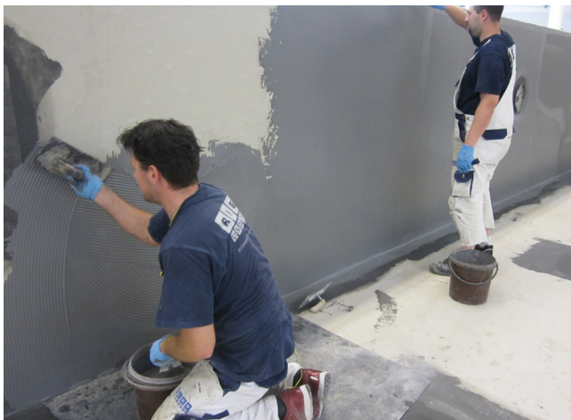
Uszczelnienie zespolone Sopro TDS 823 nakładane metodą szpachlowania.
