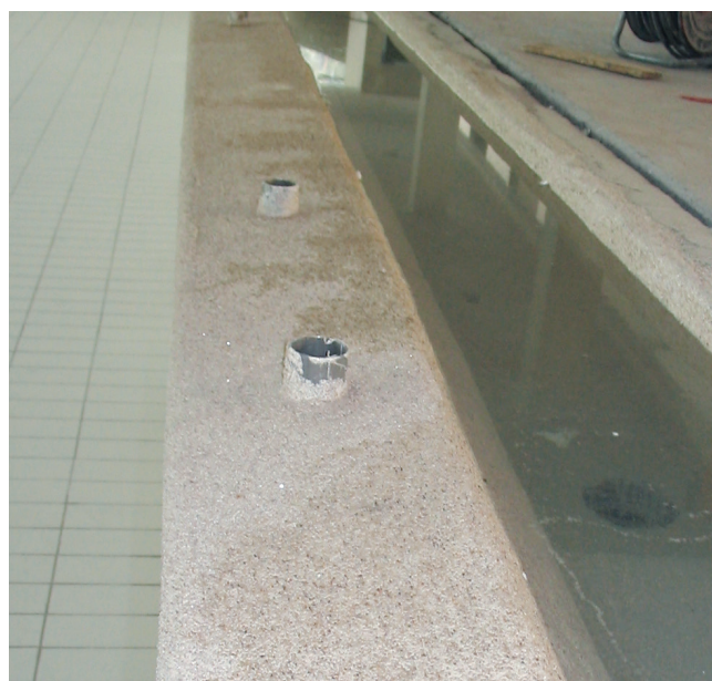
Tuleje montażowe w główce niecki basenowej do późniejszego zamontowania słupków.
