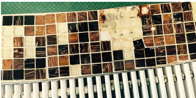
Odspojone elementy mozaiki szklanej w obszarze przelewu wokół niecki basenowej.
