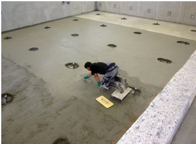
Wykonanie jastrychu zespolonego o możliwości szybkiego użytkowania, np. z zastosowaniem Sopro Rapidur® B5. Jako mostek szczerwony został użyty Sopro EPG 1522.
