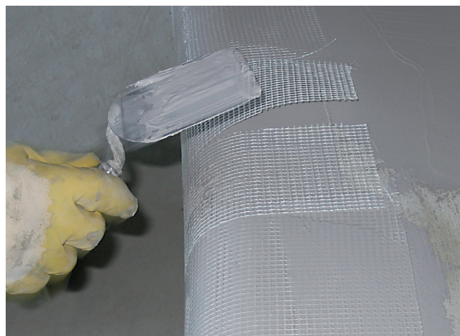
4 Wklejenie siatki z włókna szklanego w uszczelnienie zespolone w obszarze podwodnym.
