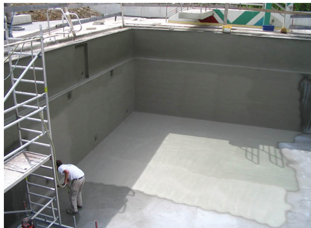
Uszczelnienie niecki basenowej metoda natryskową.
