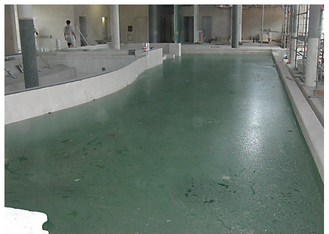
Próba szczelności niecki basenowej (14 dni) z zastosowaniem wody chlorowanej.
