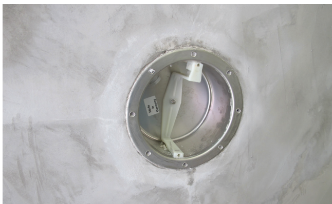
1 Reflektor zabudowany w trakcie betonowania niecki.
