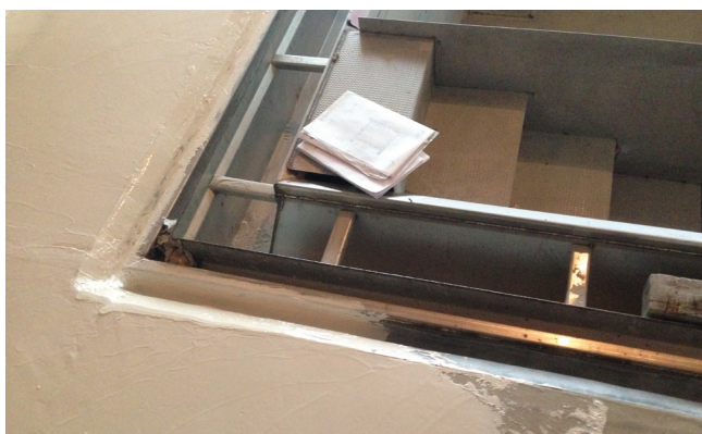
5 Uszczelnienie krawędzi (kołnierza) niecki stalowej uszczelnieniem reaktywnym Sopro PU-FD 1570.
