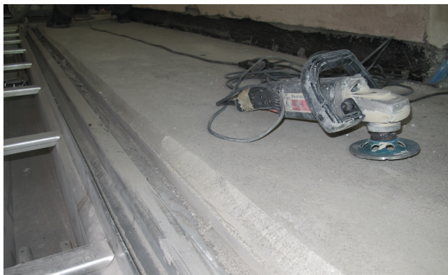
1 Przygotowanie/sfazowanie krawędzi jastrychu wokół niecki stalowej pod prace uszczelniające.
