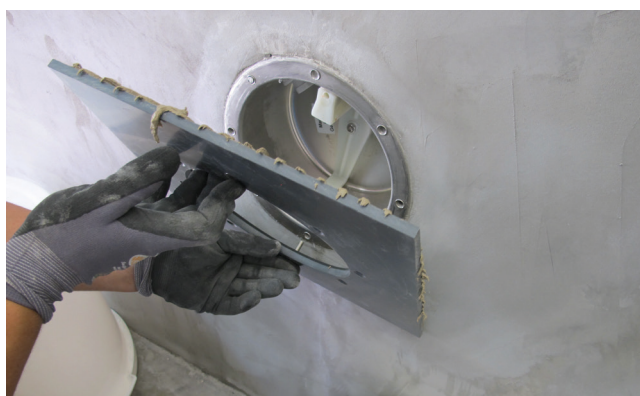
4 Osadzenie i przykręcenie kołnierza.
