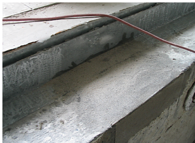
Skrzynka odpływowa pokryta żywicą reaktywną i siatką.
