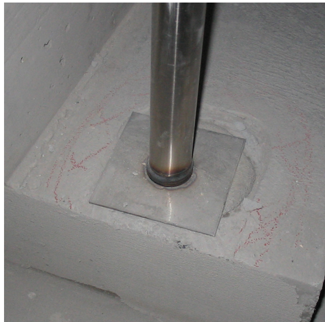
Słupek z kołnierzem montażowym, zamocowany na schodach.
