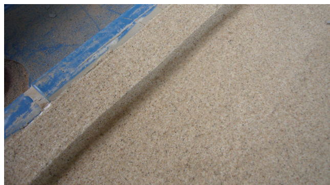
Wykonanie fugi antykapilarnej za rynną przelewową stanowi idealne rozwiązanie.
