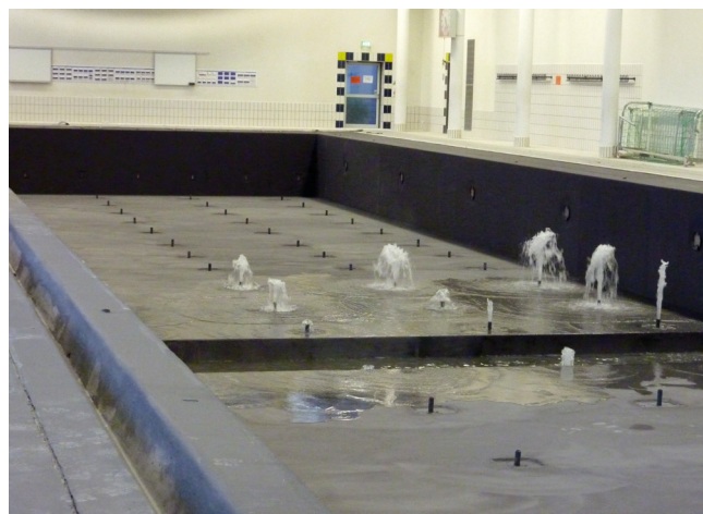
2 Niecka basenowa, uszczelniona zaprawą Sopro DSF® 423/523, przed próbą wodną.
