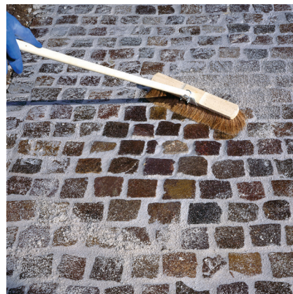
Oczyszczenie zaspoinowanej nawierzchni.
