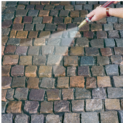
Zwilżona, oczyszczona kamienna kostka brukowa, przygotowana do spoinowania.
