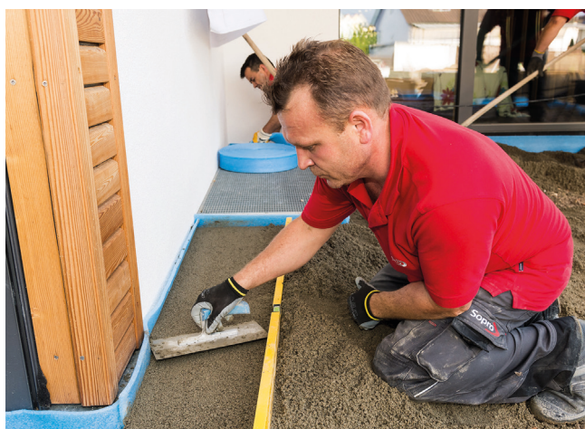
Zagęszczenie i wyrównanie warstwy drenażowej Sopro DM 610 na wymaganą wysokość.
