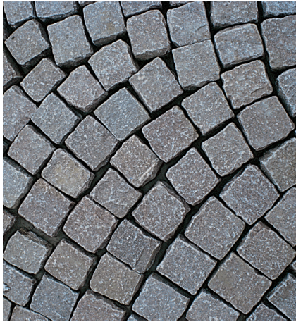
Nawierzchnia z kostki kamiennej o różnych szerokościach spoin, przygotowana do wypełnienia wysokowytrzymałą fugą cementową Sopro PFM.
