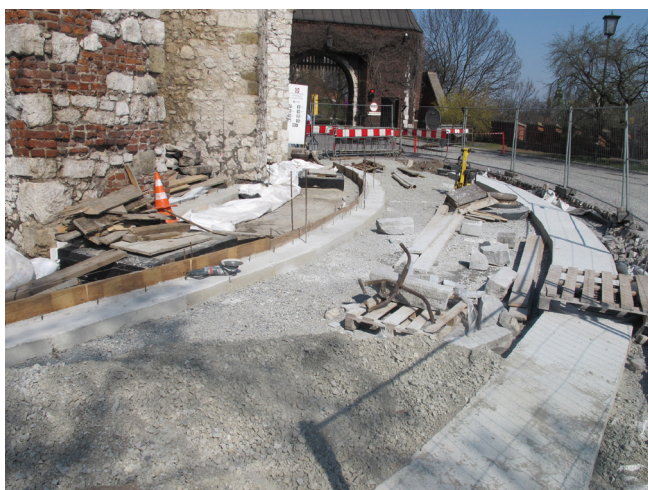
Wybetonowany fundament pod uliczny kanał odwadniający.
