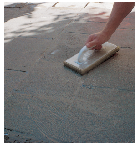
Czyszczenie małych powierzchni packą gąbkową.
