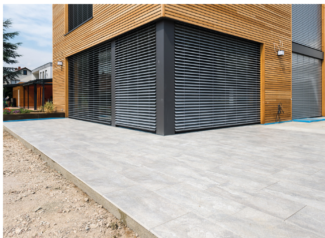
Po wyschnięciu kleju, okładzina gotowa do rozpoczęcia fugowania zaprawą Sopro FL plus.
