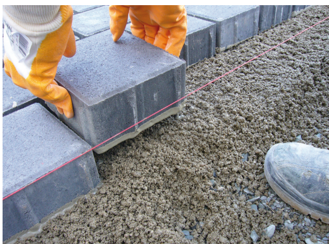
Układanie kostki brukowej metodą „mokre na mokre”, czyli z użyciem zaprawy szcypnej Sopro HSF 748, naniesionej na spód kostki i osadzonej w świeżej warstwie zaprawy drenażowej Sopro DM 610.
