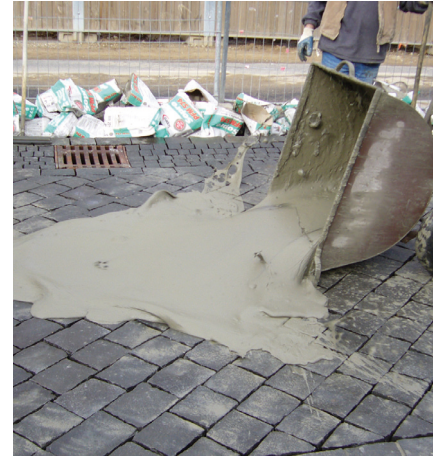
Łatwe wypełnianie spoin dzięki wysokiej rozplywności zaprawy fugowej.
