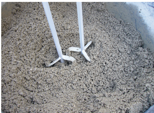
Przygotowanie zaprawy drenażowej, stosowanej jako podsypka, przy pomocy mieszadła lub betoniarki przeciwbieżnej.
