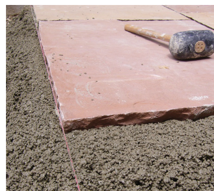
Płyta z kamienia naturalnego ułożona na podsypce o odpowiedniej grubości.
