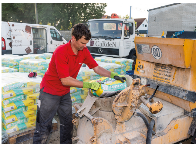
Przygotowanie zaprawy drenażowej Sopro DM 610, stosowanej jako podkład (podsypka) pod grube okładziny tarasowe.
