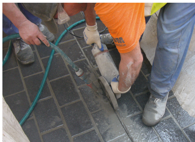
Wykonanie szczeliny dylatacyjnej w nawierzchni drogowej.
