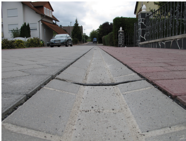
Obecnie uliczne kanały odwadniające budowane są z betonowych kształtek brukowych.
