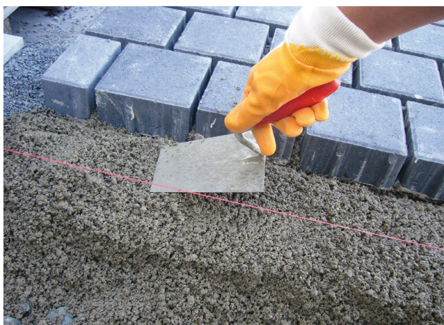
Przygotowanie zaprawy drenażowej, stosowanej jako podsypka, przy pomocy mieszadła lub betoniarki przeciwbieżnej.
