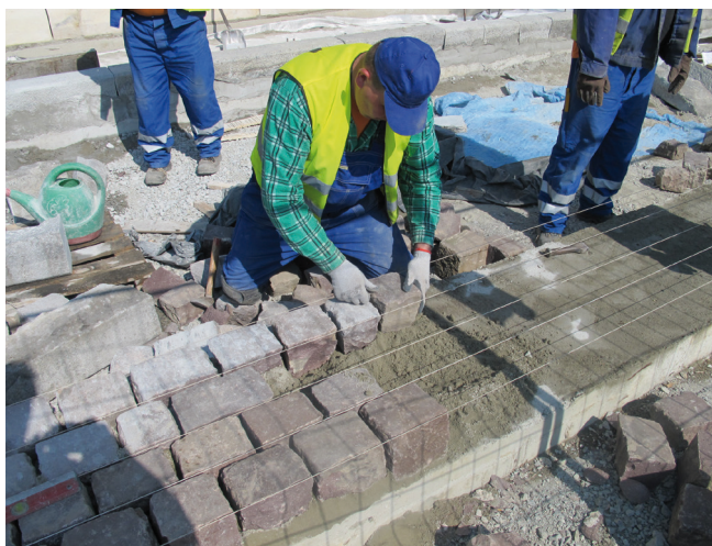
Kostka kamienna układana na hydraulicznie-wiążącym, wodoprzepuszczalnym podkładzie betonowym (podsypce).
