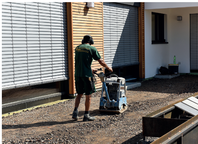
Zagęszczenie warstwy nośnej.
