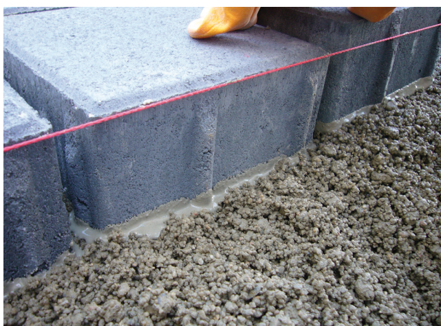
Optymalna przyczepność między zaprawą drenażową Sopro DM 610, a kostkami brukowymi, uzyskana dzięki zastosowaniu zaprawy szcypnej Sopro HSF 748.
