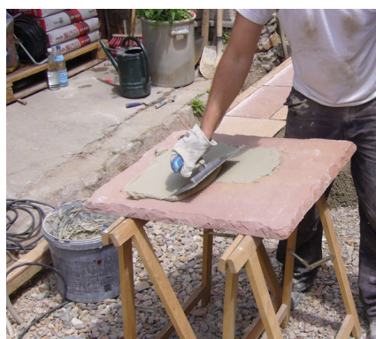
Dla trwałości konstrukcji, szczególnie przy układaniu dużych płyt zasadnicze znaczenie ma naniesienie podkładu szepnego na spód płyty i montaż metodą „mokre na mokre”.
