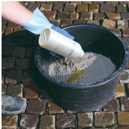
Dozowanie utwardzacza do mieszanki piaskowo-żywiczej.
