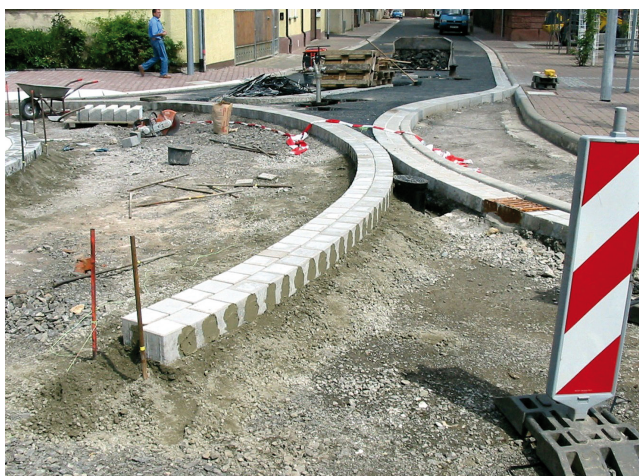
Betonowe kostki brukowe, tworzące kanał odwadniający, układane na betonowej warstwie nośnej.
