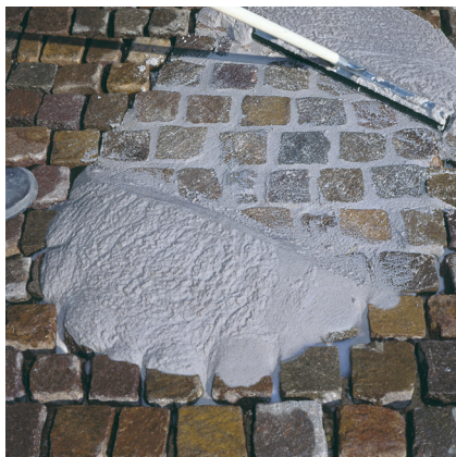
Rozprowadzanie zaprawy fugowej i dokładne wypełnienie szczelin.
