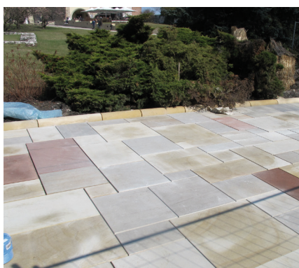
Wielkoformatowe płyty z kamienia naturalnego ułożone na związanej warstwie nośnej.
