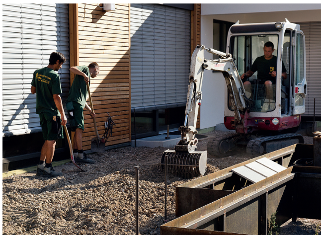
Wykonanie mrozoodpornej, niezwiązanej warstwy nośnej.
