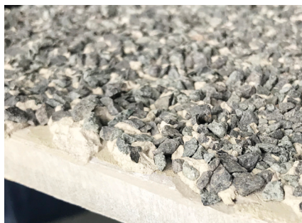
Kruszywo związane klejem, wyraźnie widoczne na spodzie płyty.
