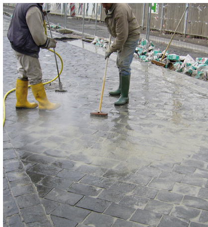
Czyszczenie nawierzchni rozproszonym strumieniem wody.
