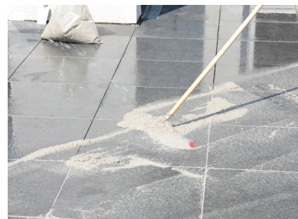
Łatwe spoinowanie żywiczną fugą drenażową Sopro Solitär® F20.
