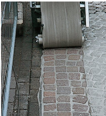
Czyszczenie dużych powierzchni przy pomocy maszyny zmywającej.
