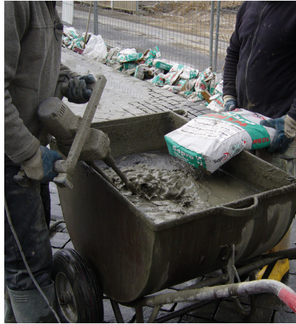
Mieszanie zaprawy Sopro PFM.
