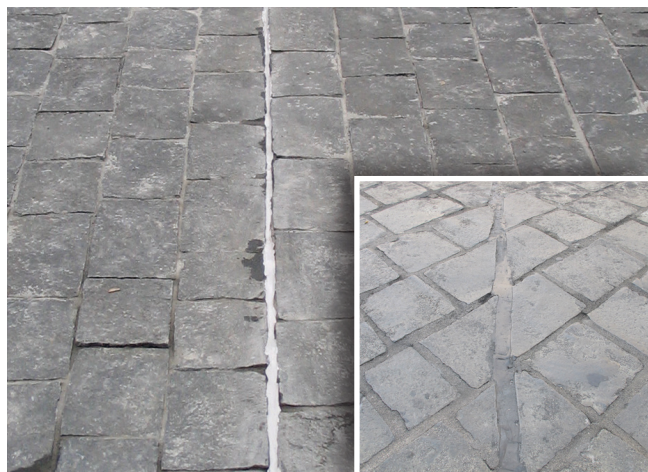
Dylatacja wypełniona trwale elastycznym materiałem uszczelniającym Sopro PUD 682 lub Sopro TDS 823.
