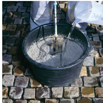
Mechaniczne mieszanie zaprawy epoksydowej Sopro EPF z dodatkiem ok. 2 l wody.
