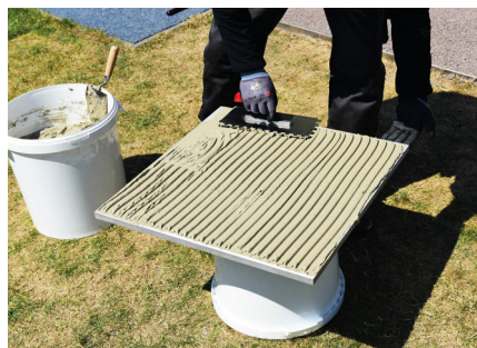
Klej Sopro No.1 400 extra naniesiony na spód płyty.
