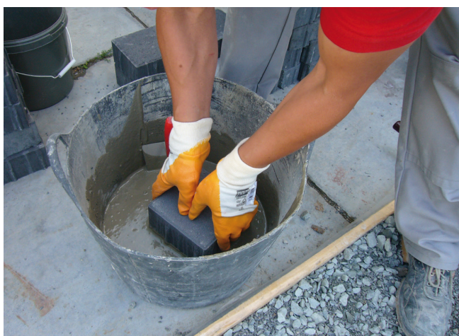
Zanurzenie spodu kostki w zaprawie szcypnej Sopro HSF 748.
