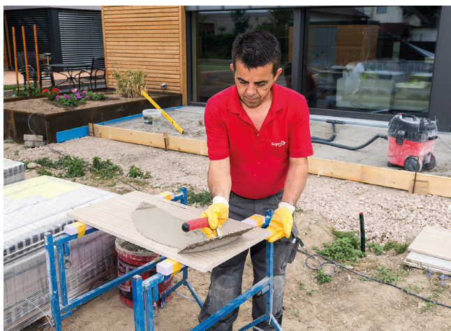
Nakładanie kleju Sopro MEG 667 Silver na spód płyty. Klejenie wykonywane tzw. metodą kombinowaną w celu uzyskania pełnego przylegania.
