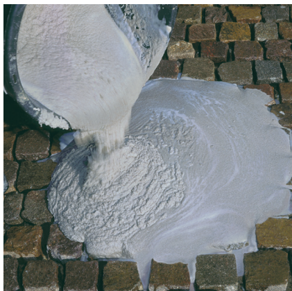
Rozpoczęcie aplikacji zaprawy fugowej Sopro EPF.
