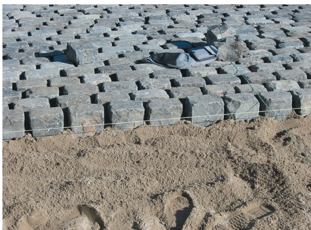
Układanie kamiennej kostki brukowej na podbudowie niezwiązanej (podatnej), na podłożu żwirowo-piaskowym.
