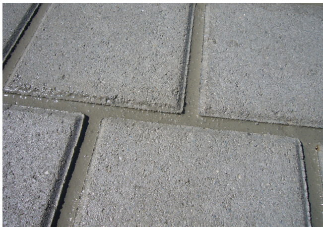
Zaprawa Sopro BSF specjalnie dostosowana do właściwości i wytrzymałości betonowej kostki brukowej.
