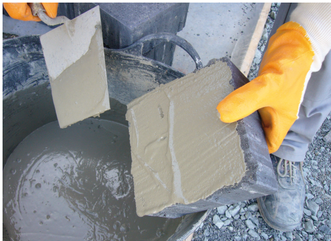
Zaprawa szczepna naniesiona kielnią na spód kostki.
