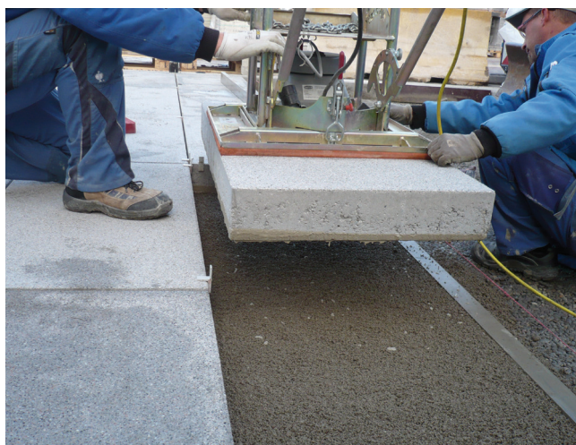
Obecnie do wykonania nawierzchni, oprócz płyt z kamienia naturalnego, stosuje się również wielkoformatowe płyty betonowe.
