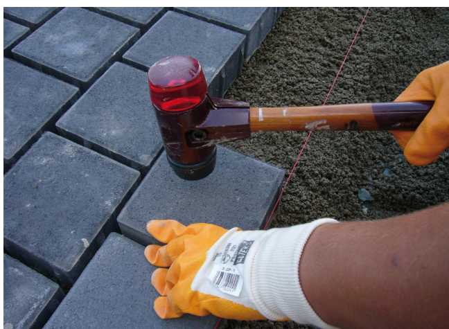
Wyrównanie powierzchni kostek, układanych metodą „pod sznur” poprzez dobijanie gumowym młotkiem, z zachowaniem ustalonej szerokości spoin.
